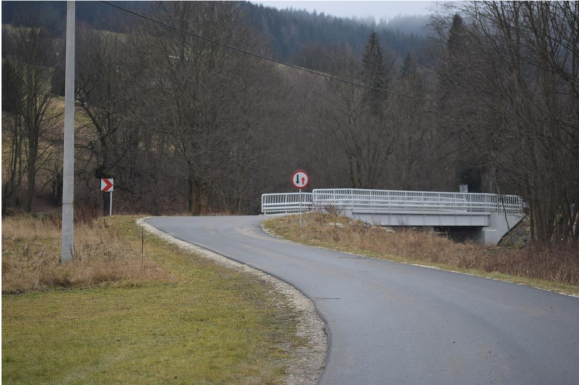
Zdj. nr 3 Środkowa część projektowanego odcinka – nawierzchnia stan dobry
