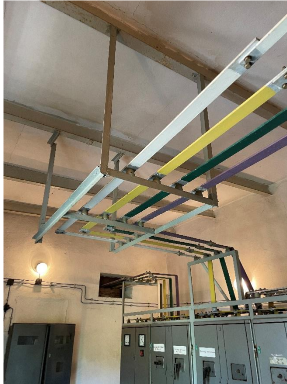
Rysunek 4: Istniejące połączenia za pomocą mostów szynowych
