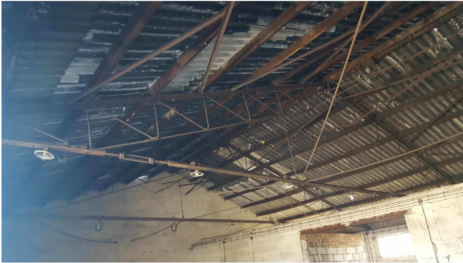
Widok na konstrukcję dachową hal
