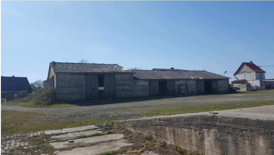
Widok ogólny na hale magazynową niską i wysoką od strony północnej
