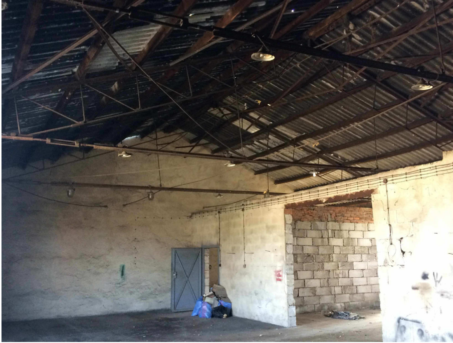
Widok na wnętrze hali niskiej. Widoczna konstrukcja dachowa i rodzaj pokrycia dachowego, konstrukcją ścian wewnętrznych.
