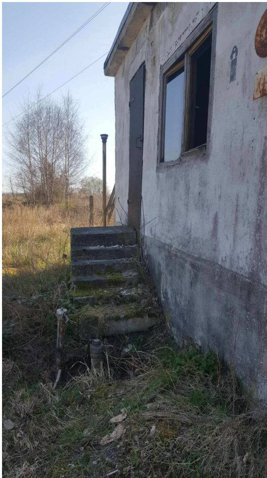
Widok na zewnętrzne schody wejściowe do budynku z uszkodzeniami i odspojeniem od ściany zewnętrznej kwalifikujące je do ponownego wykonania. Po prawej pęknięta ściana zewnętrzna, posadzka betonowa oraz prefabrykowany stropodach.
