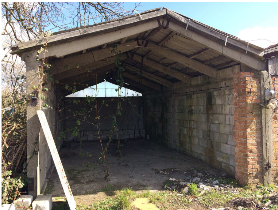
Widok na posadzkę betonową oraz ścianę łączącą garaże w konstrukcji szkieletowej betonowej wypełnionej bloczkami betonowymi
