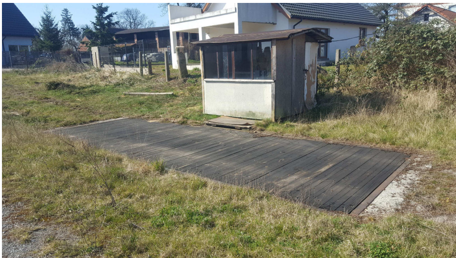
Widok ogólny na wagę wozową wraz z budynkiem wagi
