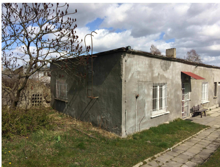
Widok na część biurową od strony południowo-zachodniej
