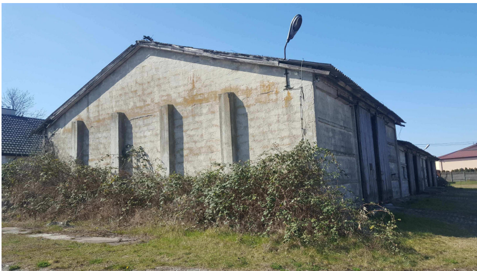
Widok od frontu na konstrukcję ścian zewnętrznych i ścianę szczytową oraz drewniane wrota wejściowe
