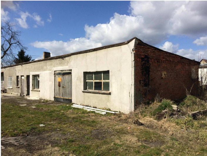
Widok na część warsztatowo – magazynową od strony południowo-wschodnie
