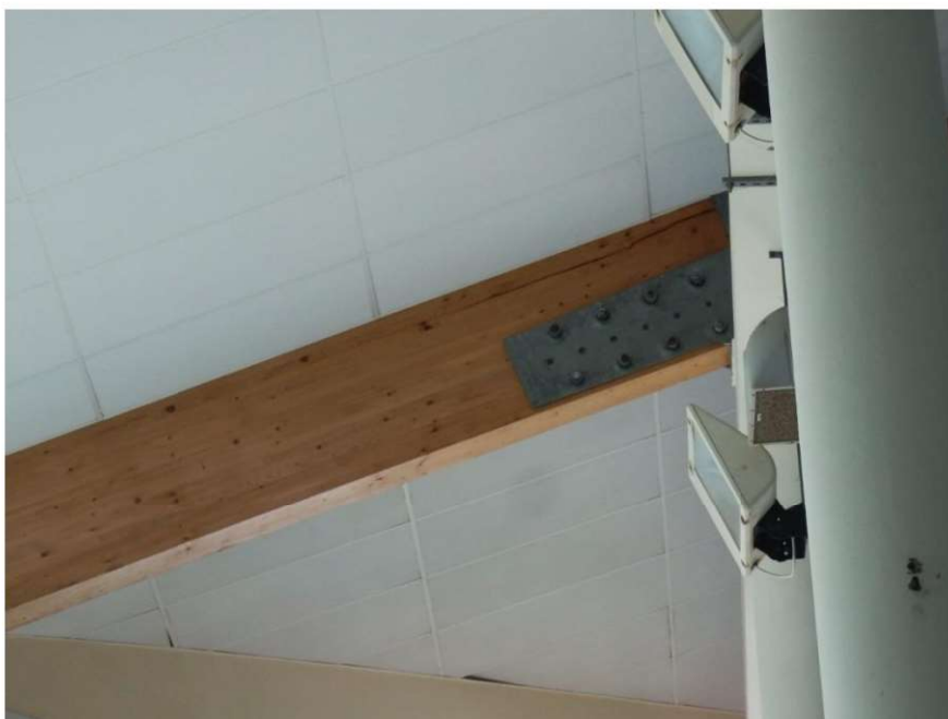
Fot. 13. Hala basenów – uszkodzona powłoka ochronna i spękania dźwigarów nad widownią
