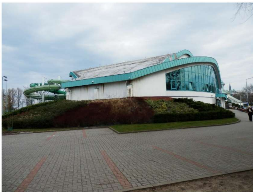
Fot. 11. Widok kompleksu Zespołu Budynków Centrum Rekreacyjno-Sportowo-Kongresowego znajdującego się przy ul. Łopuskiego w Kołobrzegu od strony zachodniej – widoczne ślady korozji mikrobiologicznej istniejącego pokrycia dachu z pianki TERMOPIAN oraz uszkodzone ofasowanie okapu
