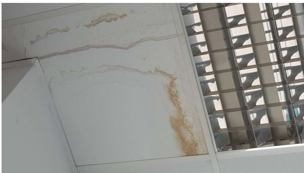
Fot. 15. Część socjalno-administracyjna – ślady po zalaniach na suficie podwieszonym
