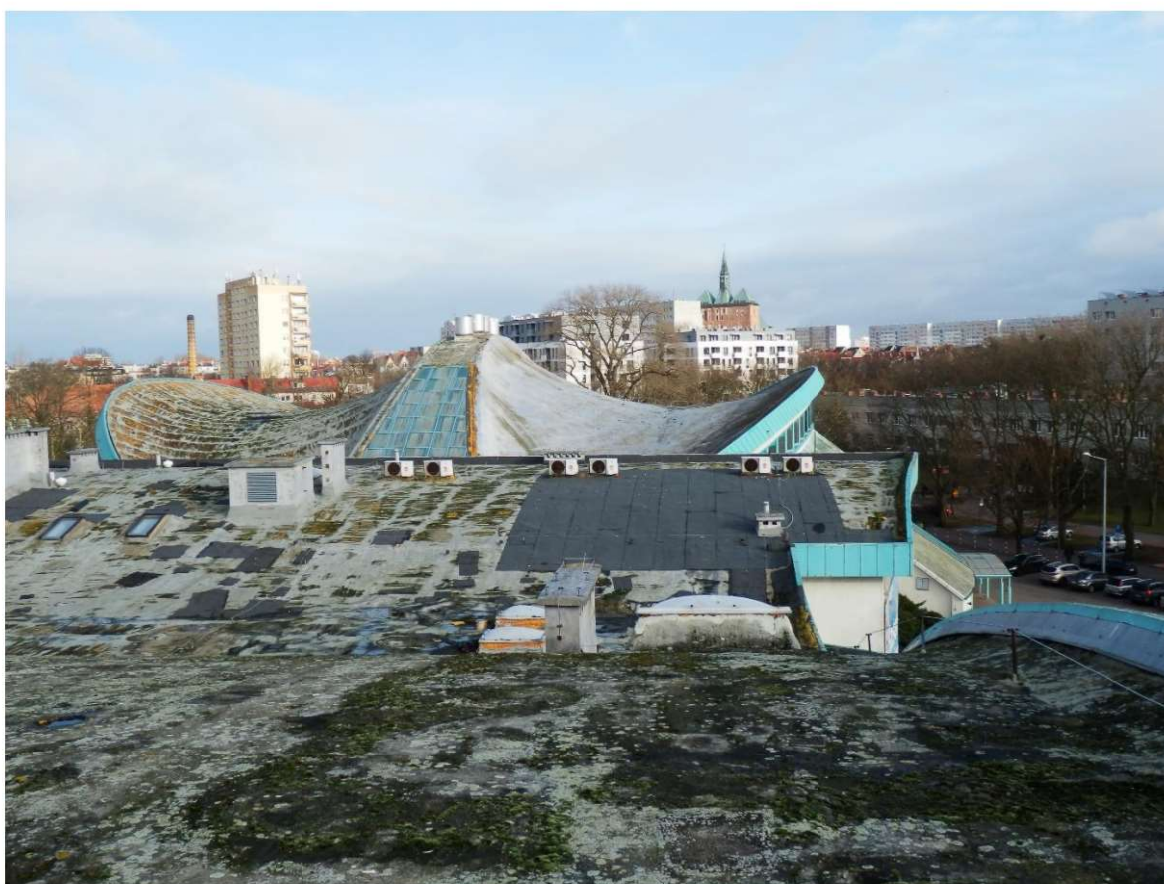
Fot. 8. Widok dachu kompleksu Zespołu Budynków Centrum Rekreacyjno-Sportowo-Kongresowego znajdującego się przy ul. Łopuskiego w Kołobrzegu- widoczne ślady korozji mikrobiologicznej istniejącego pokrycia dachu z pianki Termopian
