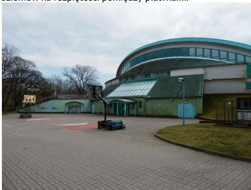
Fot. 7. Widok kompleksu Zespołu Budynków Centrum Rekreacyjno-Sportowo-Kongresowego znajdującego się przy ul. Łopuskiego w Kołobrzegu od strony północno zachodniej- widoczne ślady korozji mikrobiologicznej istniejącego pokrycia dachu z pianki Termopian
