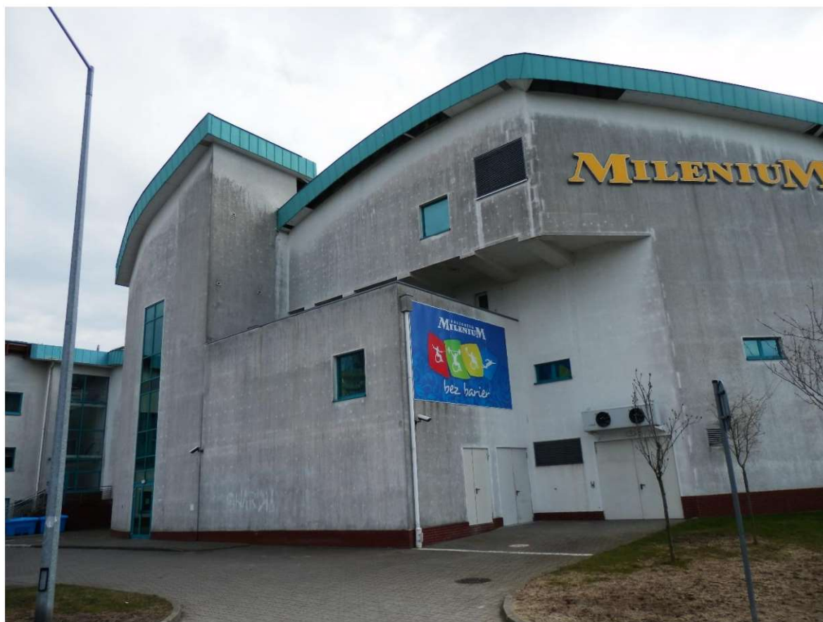
Fot. 9. Widok kompleksu Zespołu Budynków Centrum Rekreacyjno-Sportowo-Kongresowego znajdującego się przy ul. Łopuskiego w Kołobrzegu od strony północno-zachodniej – uszkodzona podsufitka okapu i ofasowanie okapu
