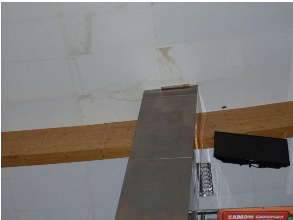
Fot. 14. Hall – wejście do pływalni – ślady po zalaniach na suficie podwieszonym
