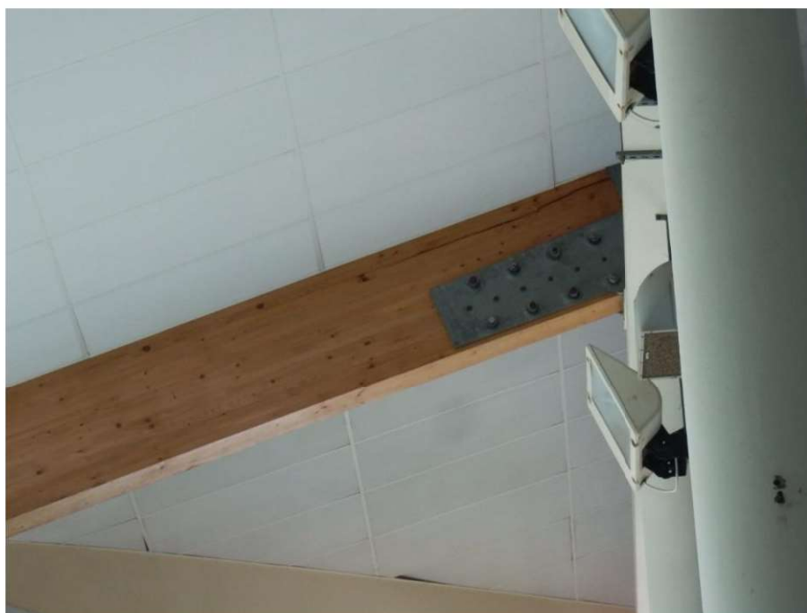
Fot. 13. Hala basenów – uszkodzona powłoka ochronna i spękania dźwigarów nad widownią
