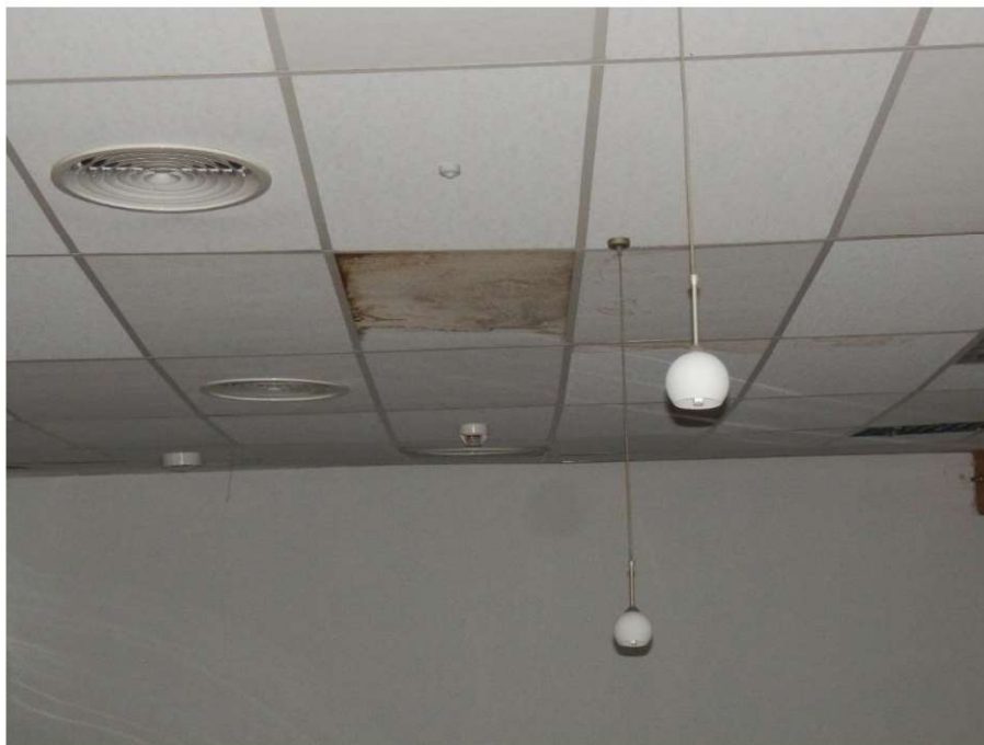
Fot. 12. Część socjalno-administracyjna – ślady po zalaniach na suficie podwieszonym
