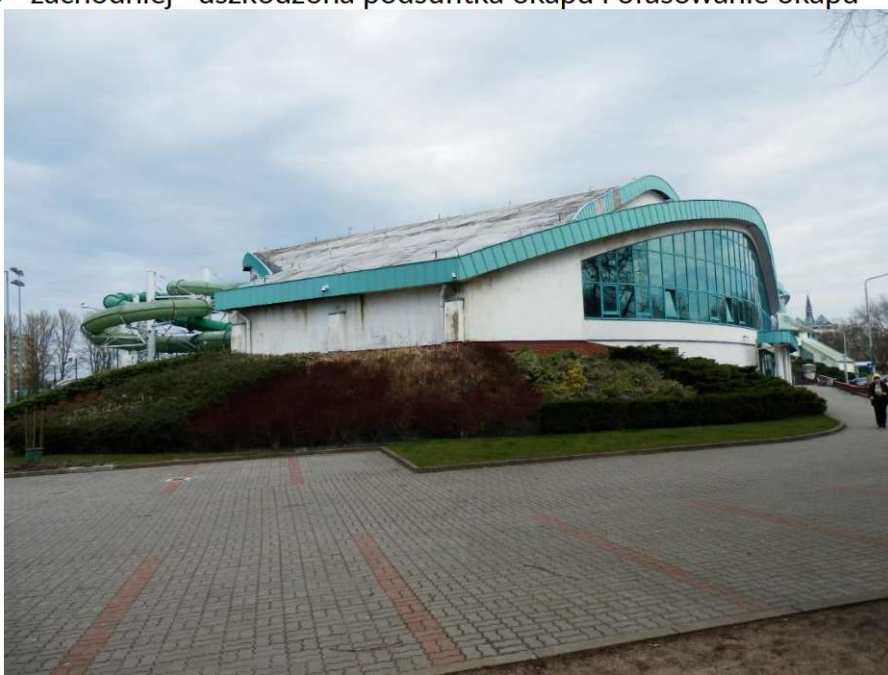
Fot. 11. Widok kompleksu Zespołu Budynków Centrum Rekreacyjno-Sportowo-Kongresowego znajdującego się przy ul. Łopuskiego w Kołobrzegu od strony zachodniej – widoczne ślady korozji mikrobiologicznej istniejącego pokrycia dachu z pianki TERMOPIAN
