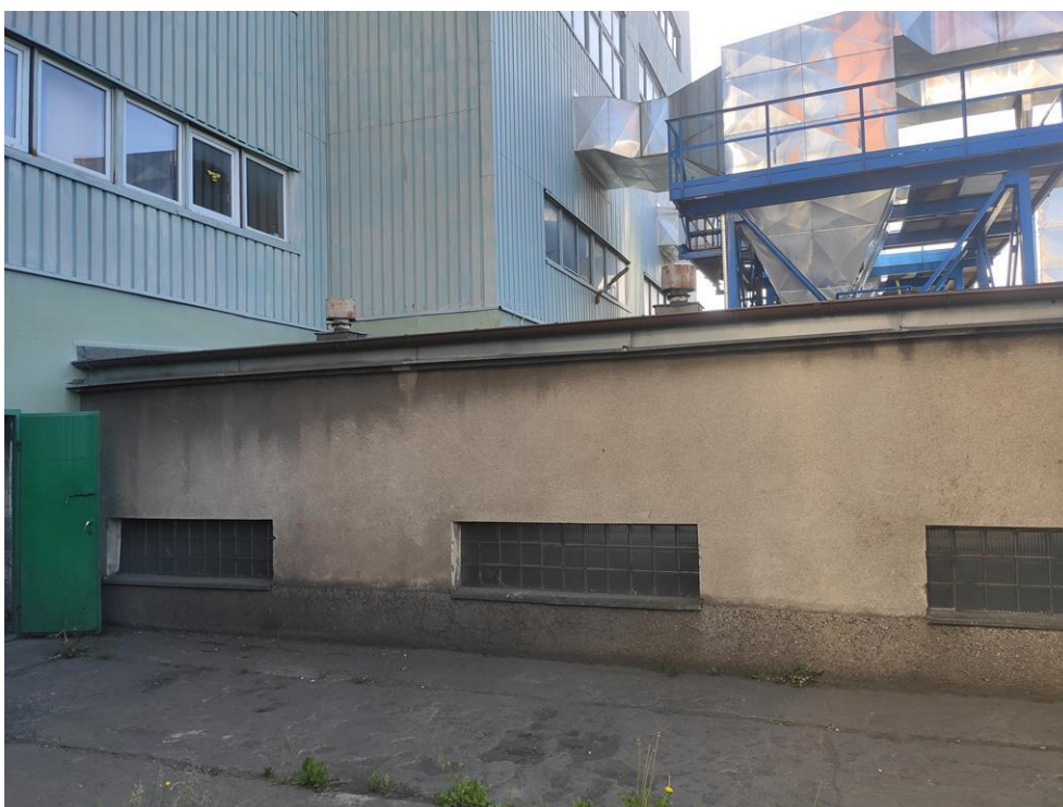
Fot.7 - Budynek „bunkier” odzuzłania – remont elewacji i malowanie farbą silikonową
