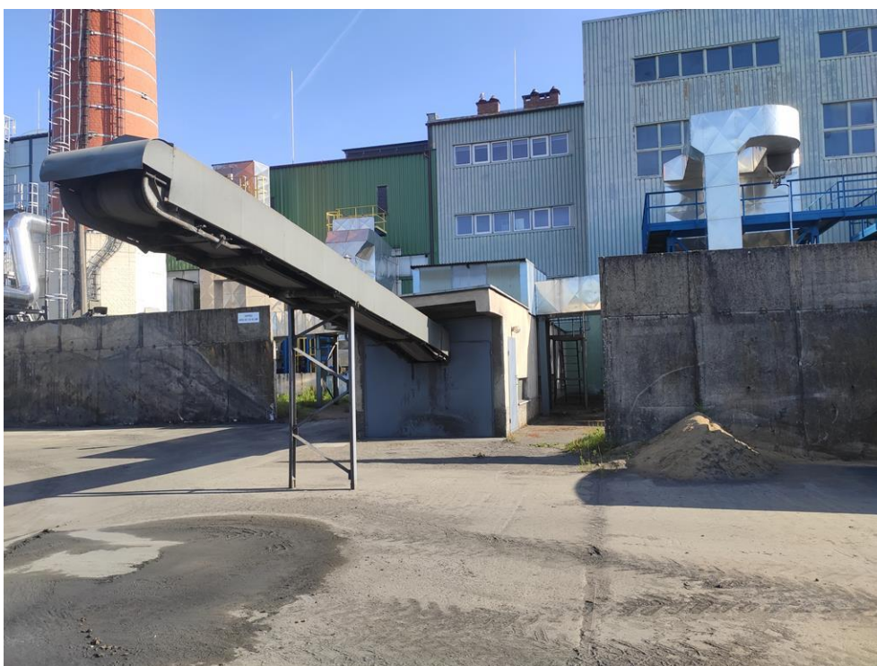
Fot.9 - Budynek „bunkier” odzuzłania – remont elewacji i malowanie farbą silikonową
