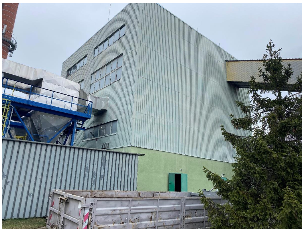
Fot.2 - Część elewacji przeznaczonej do remontu.
