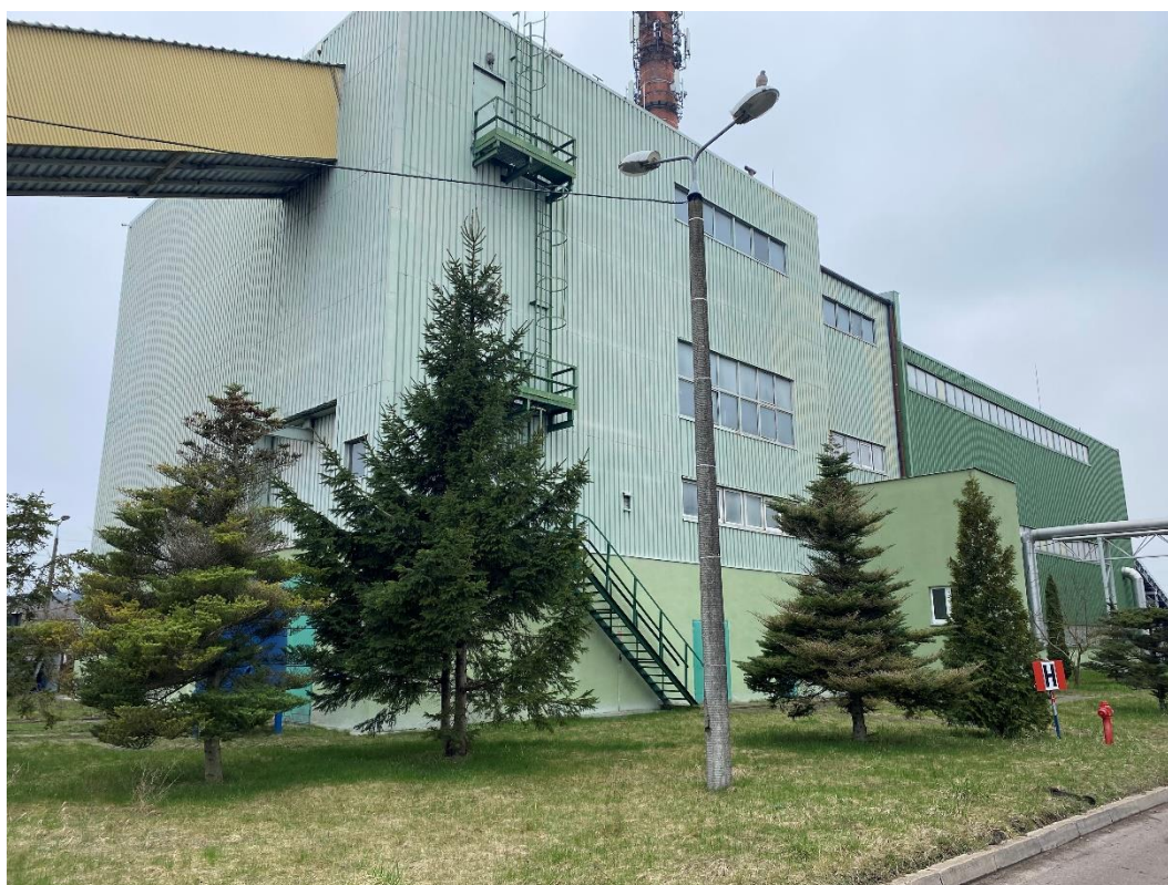
Fot.1 - Część elewacji przeznaczonej do remontu.
