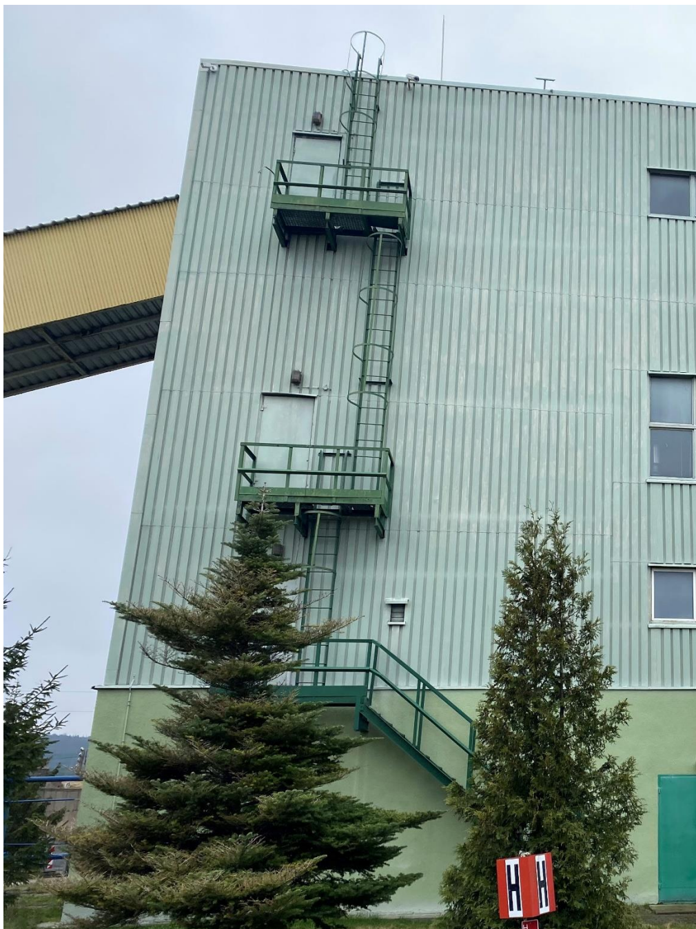
Fot.5 - Stopnice, pomosty i drabiny, drzwi, wrota, ramy okienne przeznaczone do remontu
