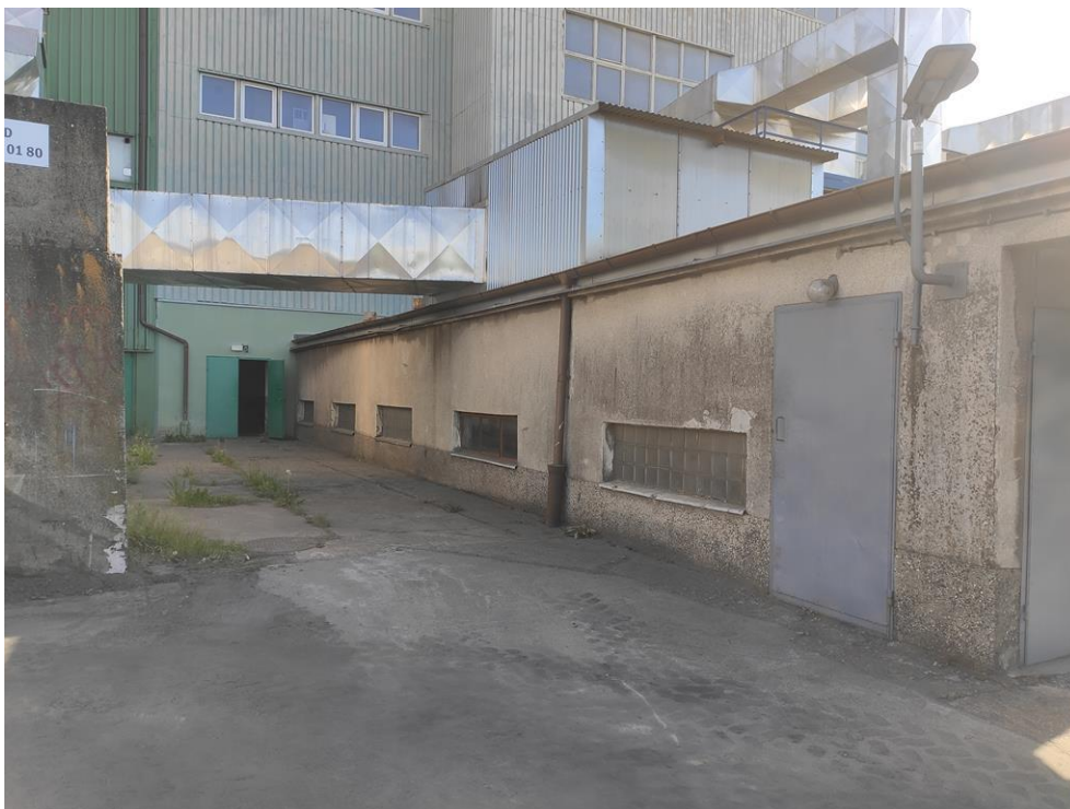
Fot.6 - Budynek „bunkier” odzuzłania – remont elewacji i malowanie farbą silikonową
