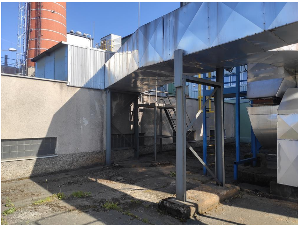
Fot.8 - Budynek „bunkier” odzuzłania – remont elewacji i malowanie farbą silikonową
