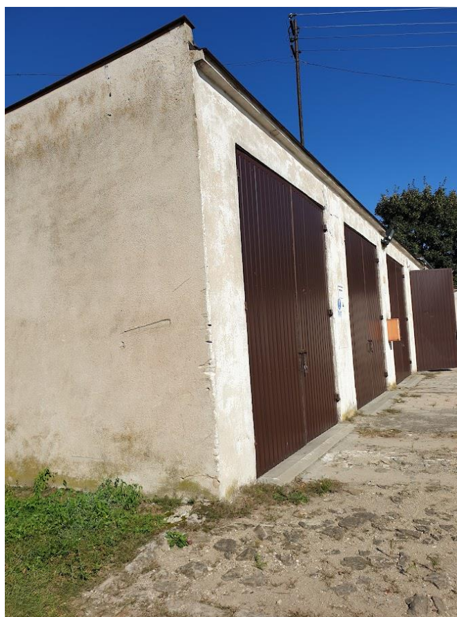
Zdjęcie nr 1 – elewacja frontowa budynku 4E
