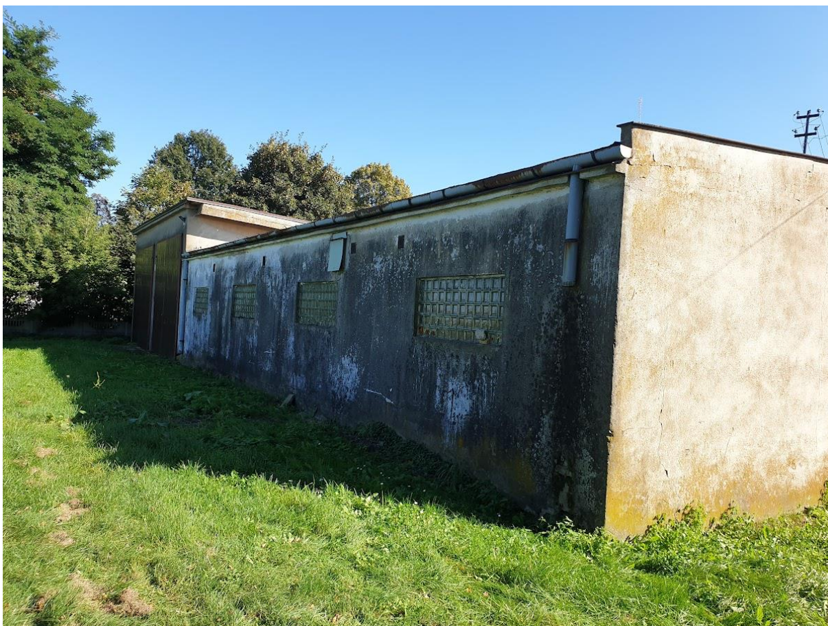
Zdjęcie nr 2 – elewacja tylna budynku 4E
