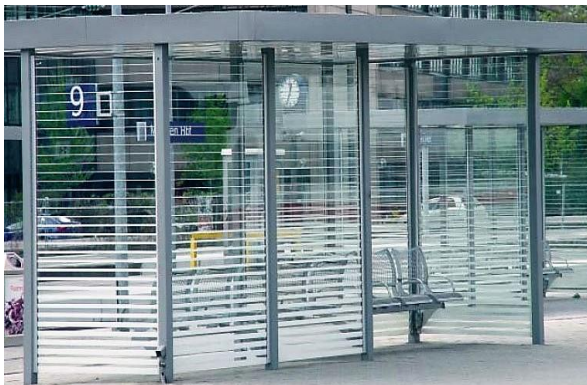
Wiata przystankowa zabezpieczona paskami różnej szerokości
