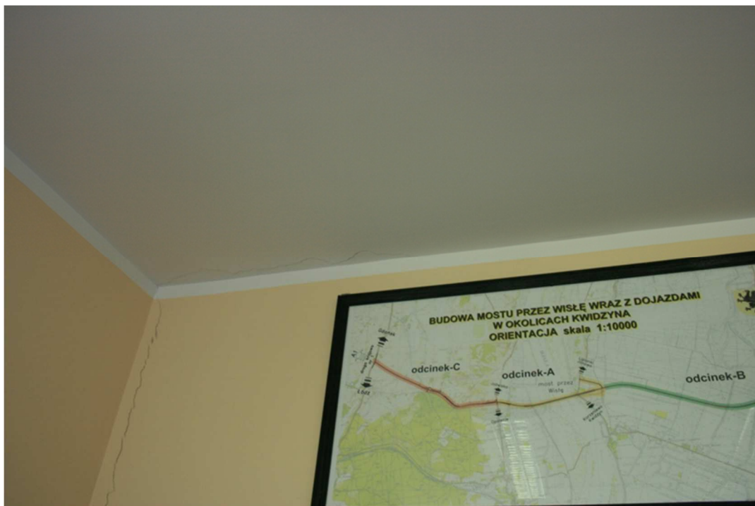
FOT. 2-3 ZARYSOWANIE ŚCIANY POPRZECZNEJ OD STRONY POMIESZCZENIA 1.2
