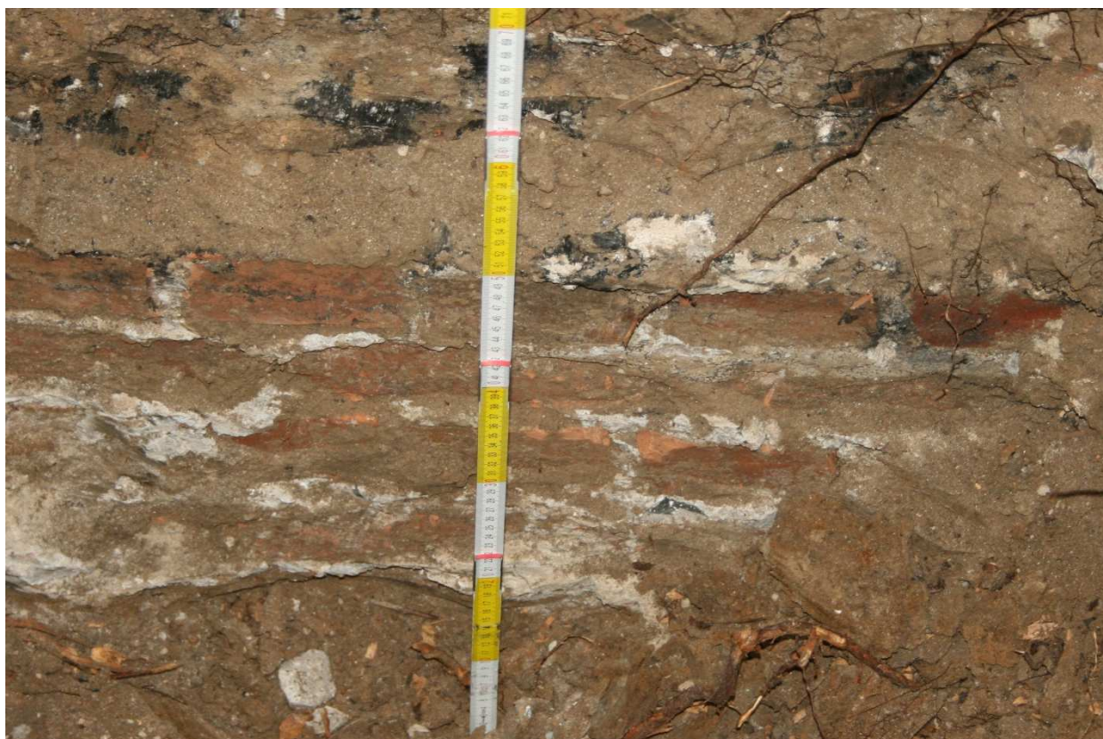
FOT. O-4 ODKRYWKA NR 1 WYSOKOŚĆ ŁAWY FUNDAMENTOWEJ ca. 50 cm
