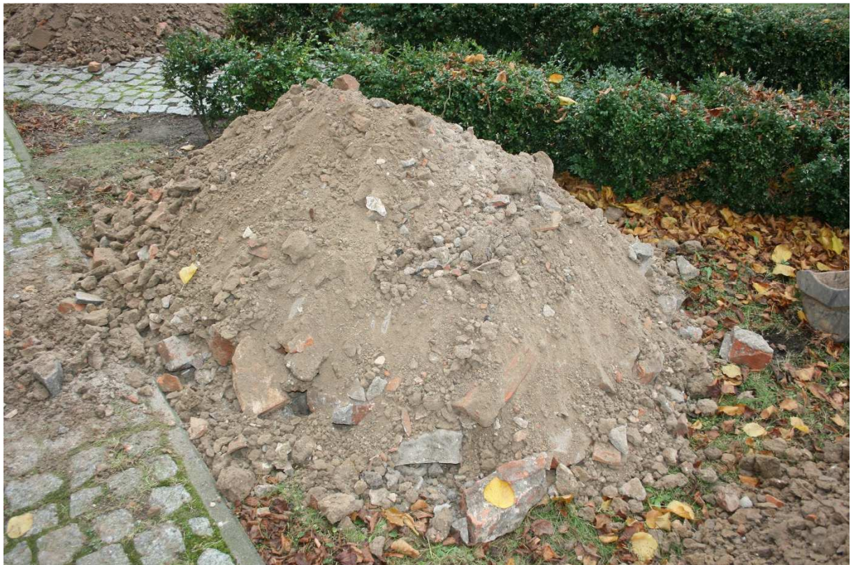
FOT. O-10 GRUNT Z WYKOPU
