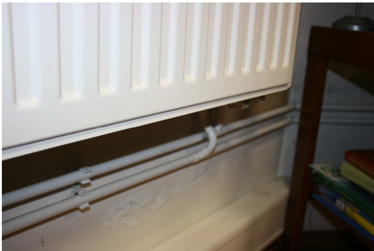
FOT. 0-5 ZAWILGOCENIE ŚCIAN POWYŻEJ POSADZKI
