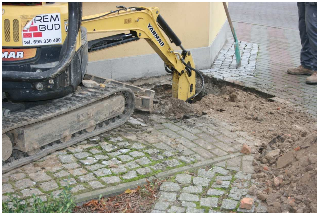
FOT. O-7 ODKRYWKA NR 3 LOKALIZACJA
