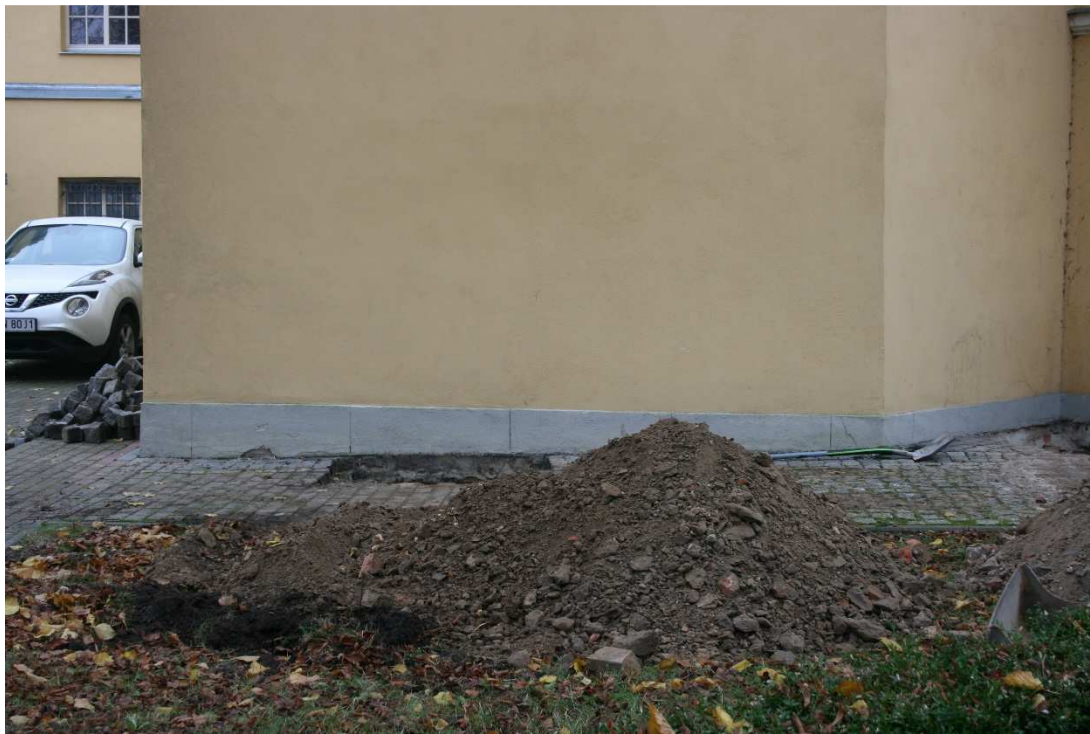
FOT. O-2 ODKRYWKA NR 1 WIDOK ŚCIANY I ŁAWY FUNDAMENTOWEJ
