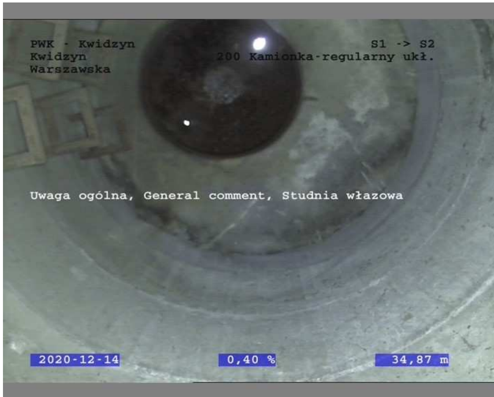
FOT. 3-1 WIDOK STUDNI S2
