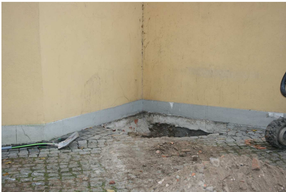
FOT. O-5 ODKRYWKA NR 2 LOKALIZACJA
