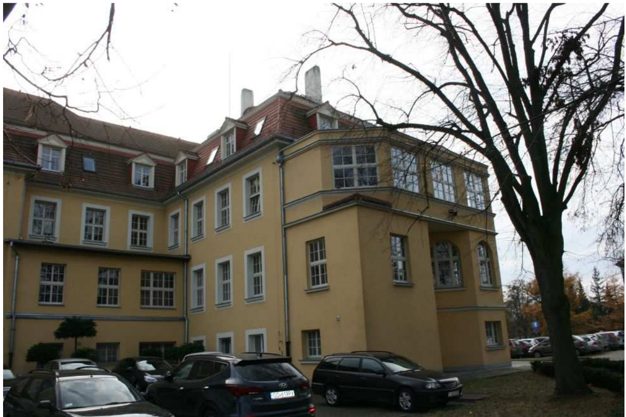
FOT. Z-3 ELEWACJA WSCHODNIA SKRZYDŁA BUDYNKU
