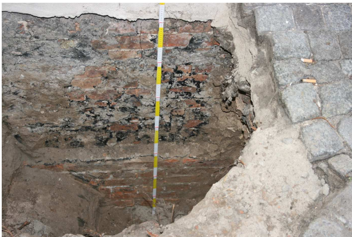
FOT. O-6 ODKRYWKA NR 2 WIDOK ŚCIANY I ŁAWY FUNDAMENTOWEJ
