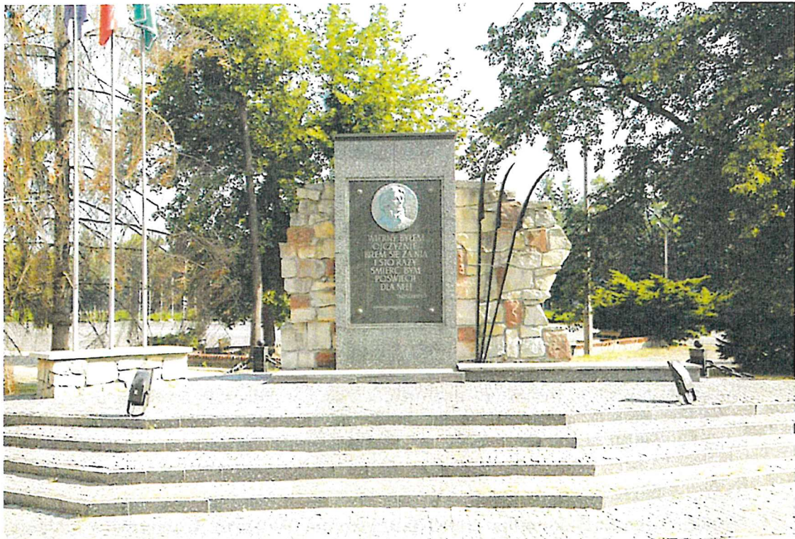
Fot. 1. Pomnik przed demontażem
