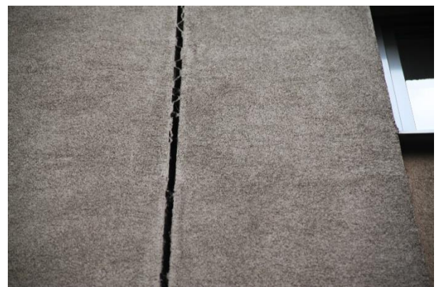
Zdjęcia górne i dolne. Brak przeniesienia dylatacji na wykonane ocieplenie oraz na okładzinę elewacyjną
