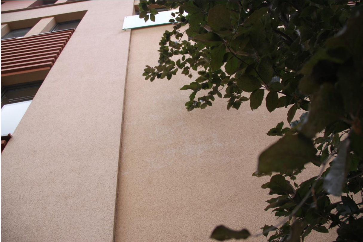
Zdjęcie górne Dylatacja budynku powstała samoistnie w warstwie ocieplenia. Brak dylatowania warstwy ocieplenia w miejscu dylatacji ścian budynku.
