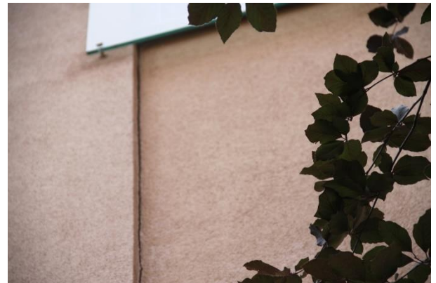
Zdjęcia górne i dolne. Brak przeniesienia dylatacji na wykonane ocieplenie oraz na okładzinę elewacyjną
