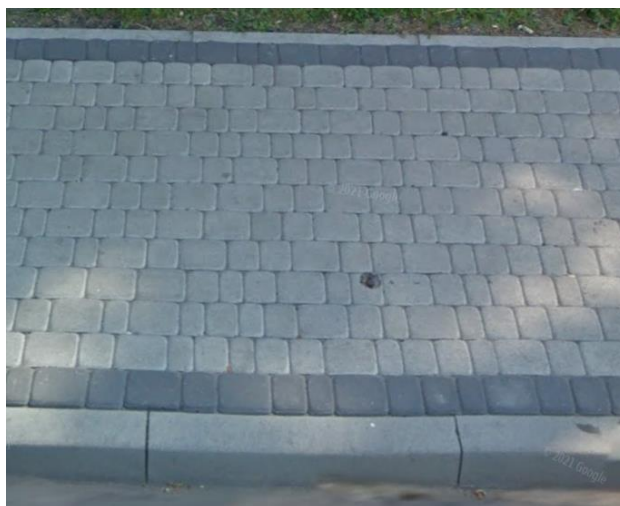
Zdj. 4. Kostka betonowa dla ciągów pieszych
