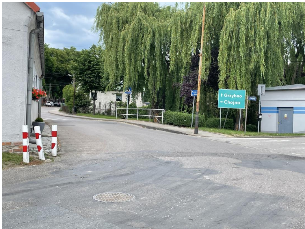
Zdj. 3 – Ist. nawierzchnia jezdni ul. Cmentarnej – początek opracowanego odcinka.
