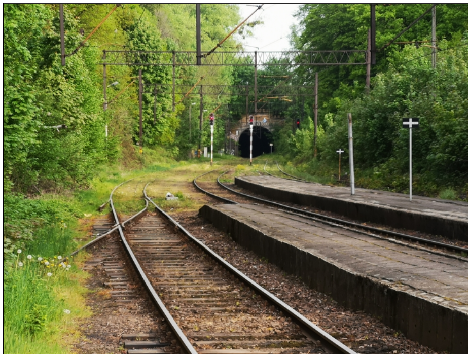
Fotografia 4 Wjazd do tunelu kolejowego
