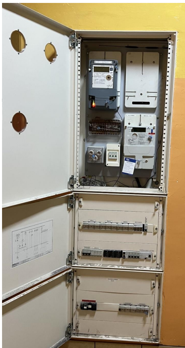
Rysunek 3.6. Zdjęcie istniejącego układu pomiarowo-rozliczeniowego (a – widok szaf frontowych, b – widok wnętrza szaf).
