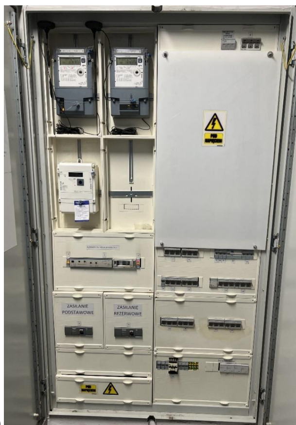
Rysunek 3.8. Zdjęcie istniejącego układu pomiarowo-rozliczeniowego (a – widok szaf frontowych, b – widok wnętrza szaf).
