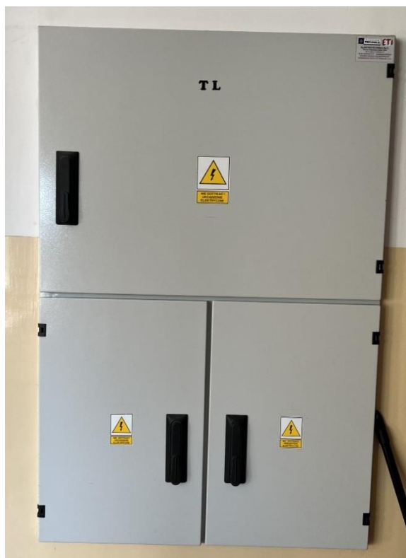
Rysunek 3.11. Zdjęcie istniejącego układu pomiarowo-rozliczeniowego (a – widok szaf frontowych, b – widok wnętrza szaf)
