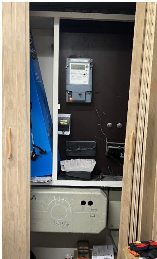
Rysunek 3.1.a. Zdjęcie istniejącego układu pomiarowo-rozliczeniowego – widok wnętrza szaf.
