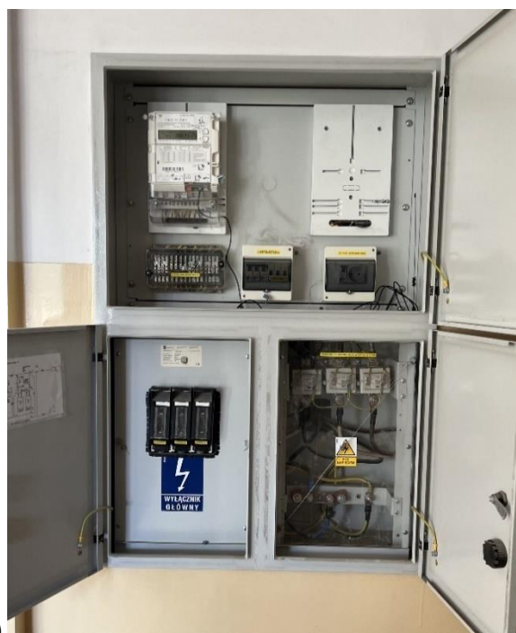
Rysunek 3.11. Zdjęcie istniejącego układu pomiarowo-rozliczeniowego (a – widok szaf frontowych, b – widok wnętrza szaf)
