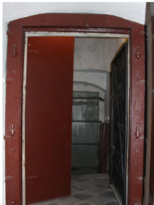
Drzwi D(a) - poziom PAERERU wejście do Sali A/00.01
