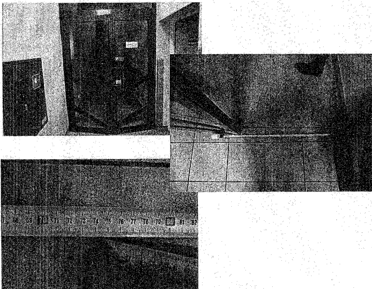
Fot. nr 2. Widok na drzwi wieloskrzydłowe w poziomie parteru zlokalizowane na poziomej drodze ewakuacyjnej (korytarz – pom. nr 0.70) o szerokości skrzydła czynnego poniżej wymaganych 0,9 m – opracowanie własne.
