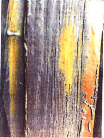
Widoczne dwie warstwy brązowe nałożone na współczesne okna obecnie eksponowane w budynku
