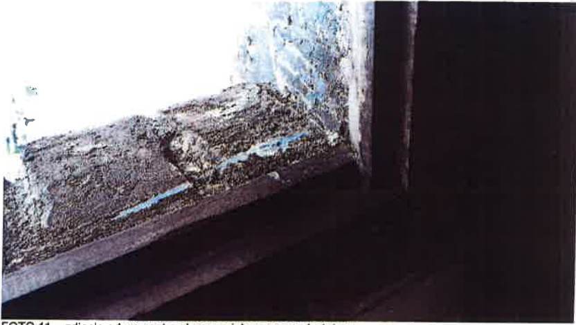
FOTO 11 - zdjęcie od wewnątrz okna ramiakowego na 1 piętrze
