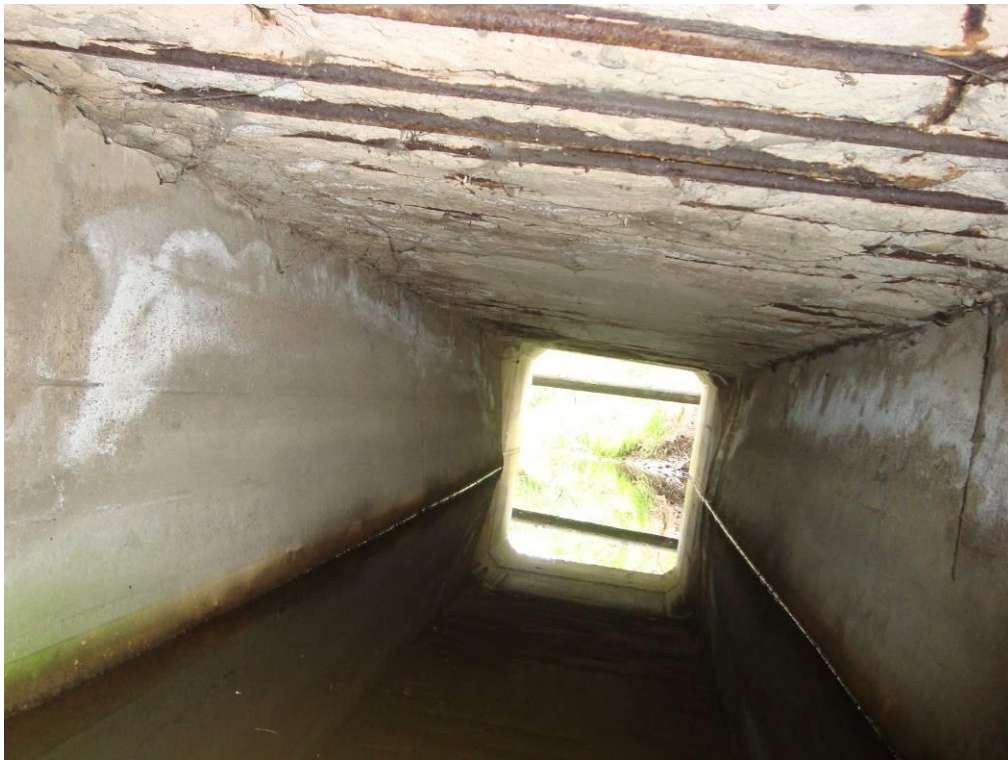
Fot. 4. Widok wnętrza przepustu w części pod jezdnią (płyta żelbetowa).
