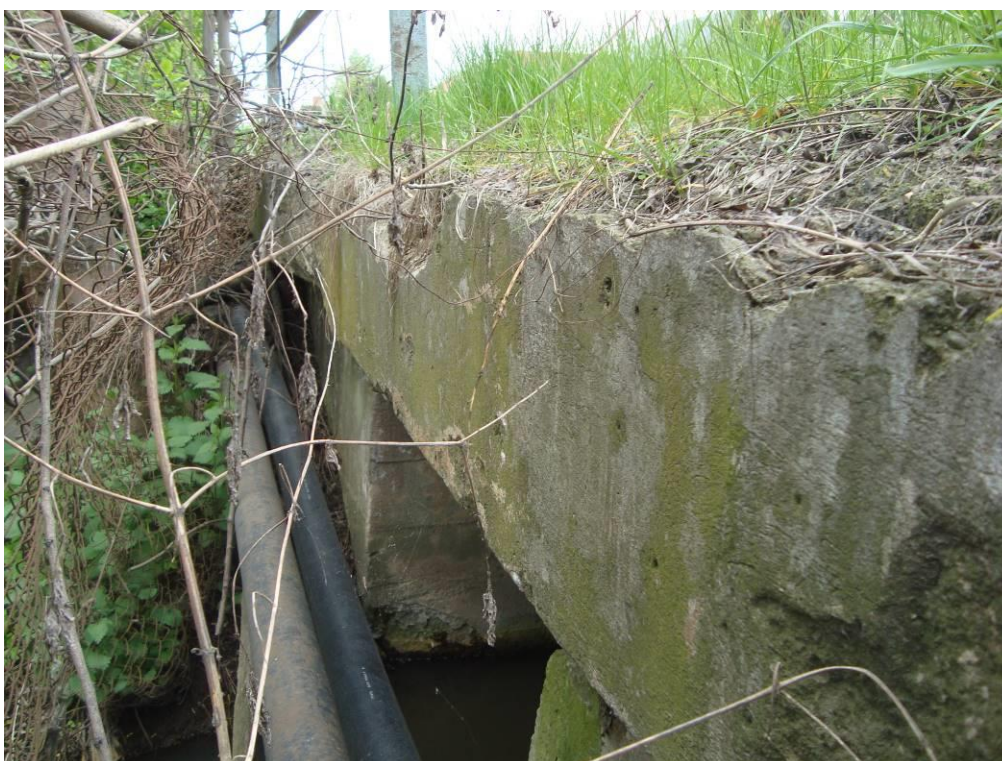
Fot. 3. Widok ściany czołowej wylotu wraz z rurami osłonowymi sieci teletechnicznych.
