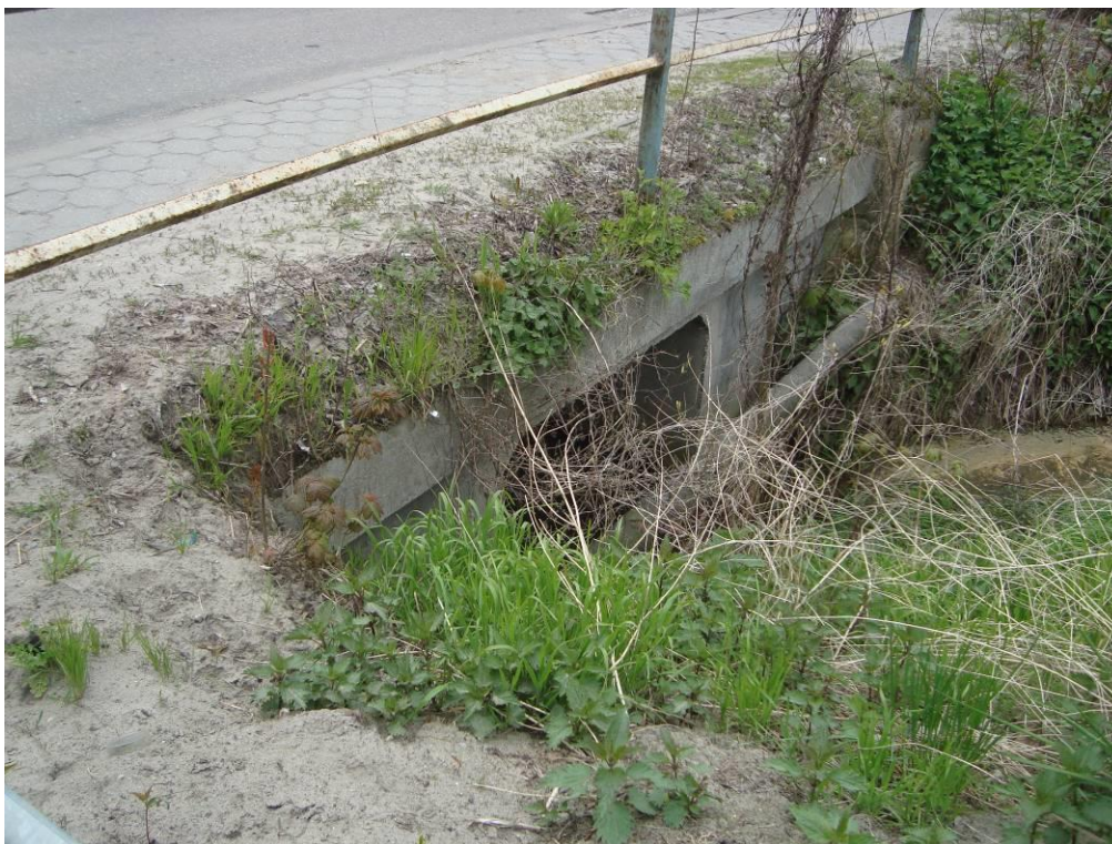
Fot. 2. Widok ściany czołowej wlotu wraz z rurą osłonową sieci gazowej.
