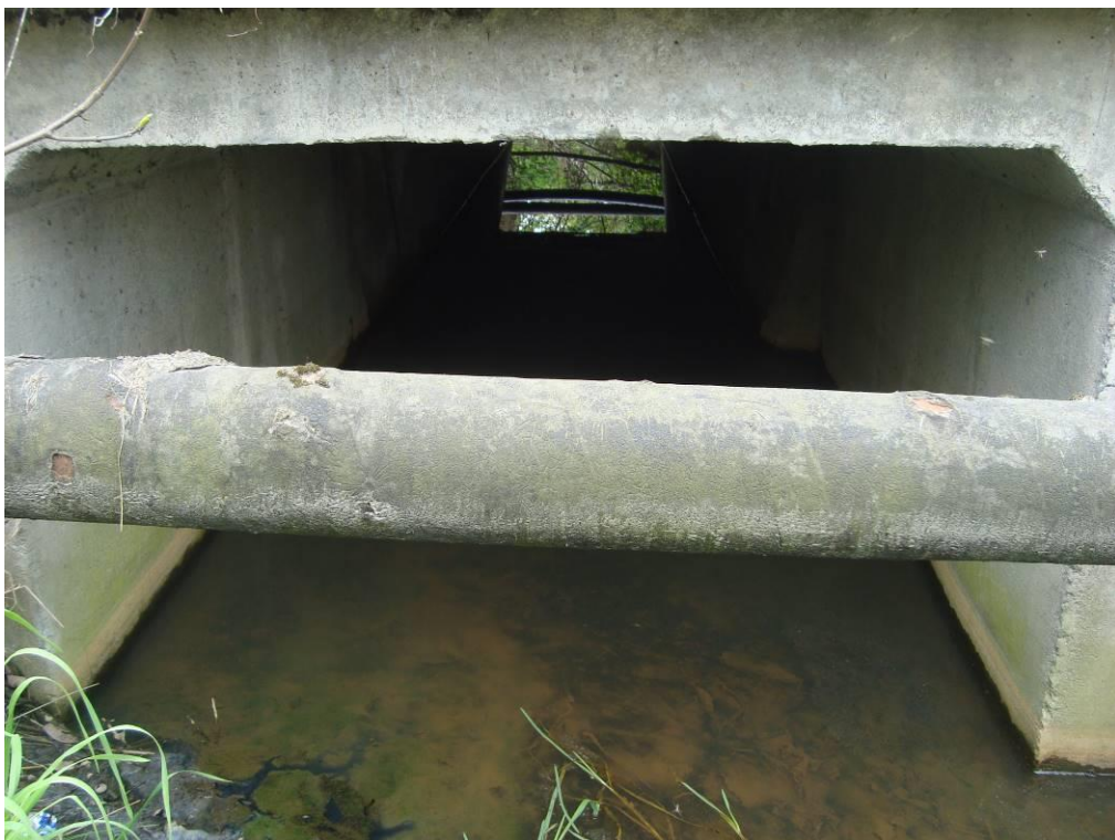
Fot. 5. Widok wnętrza przepustu w części pod chodnikiem (prefabrykaty skrzynkowe).
