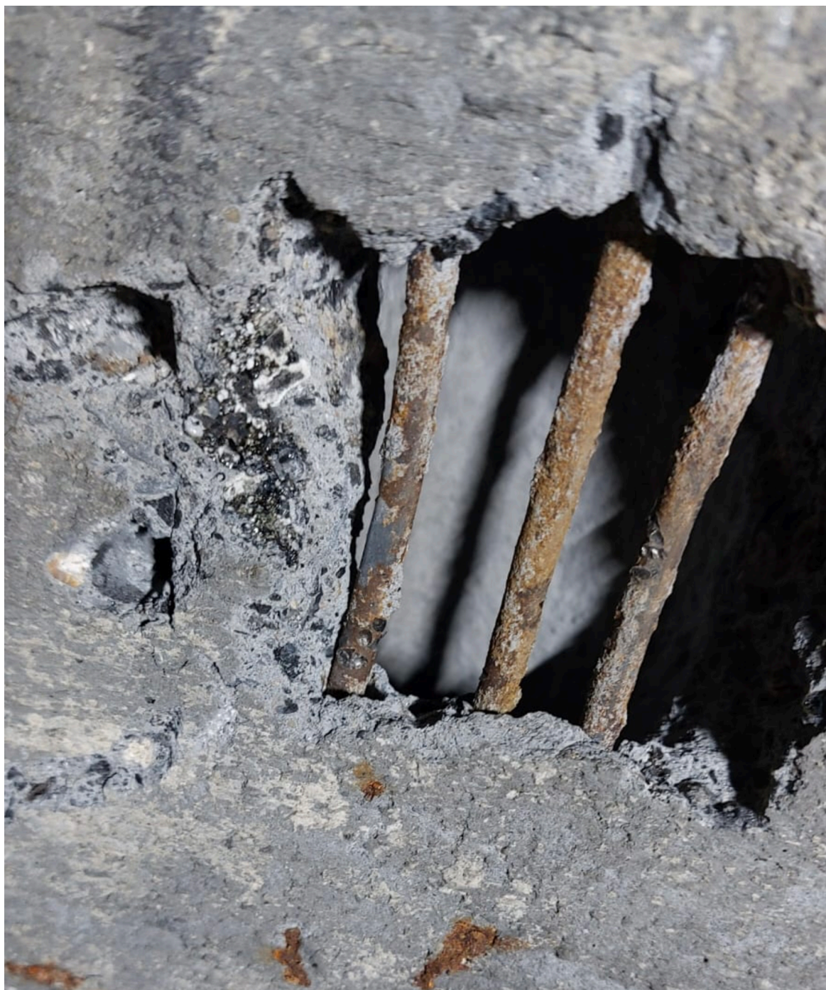
Fot. nr 6. Wygląd spodu płyt stropowych
