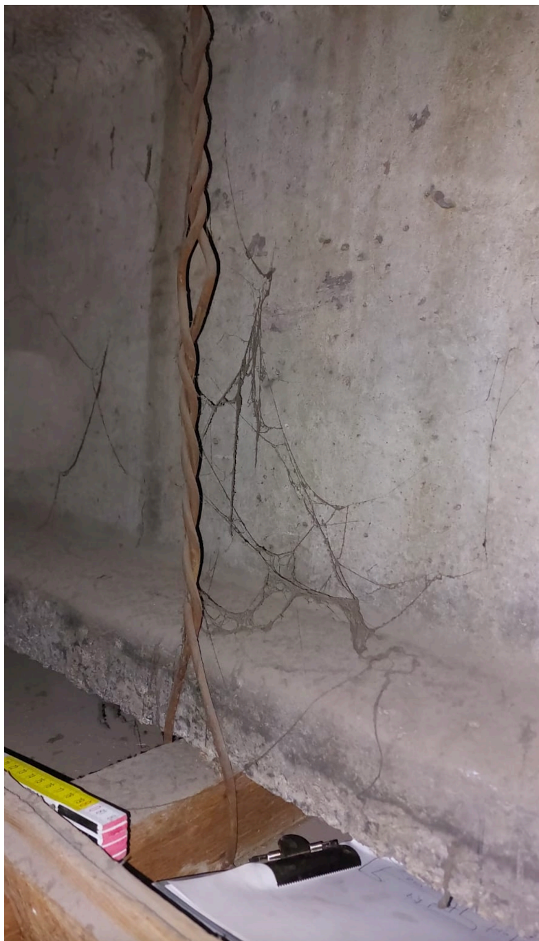
Fot. nr 7. Prosta konstrukcja sufitu podwieszonego
