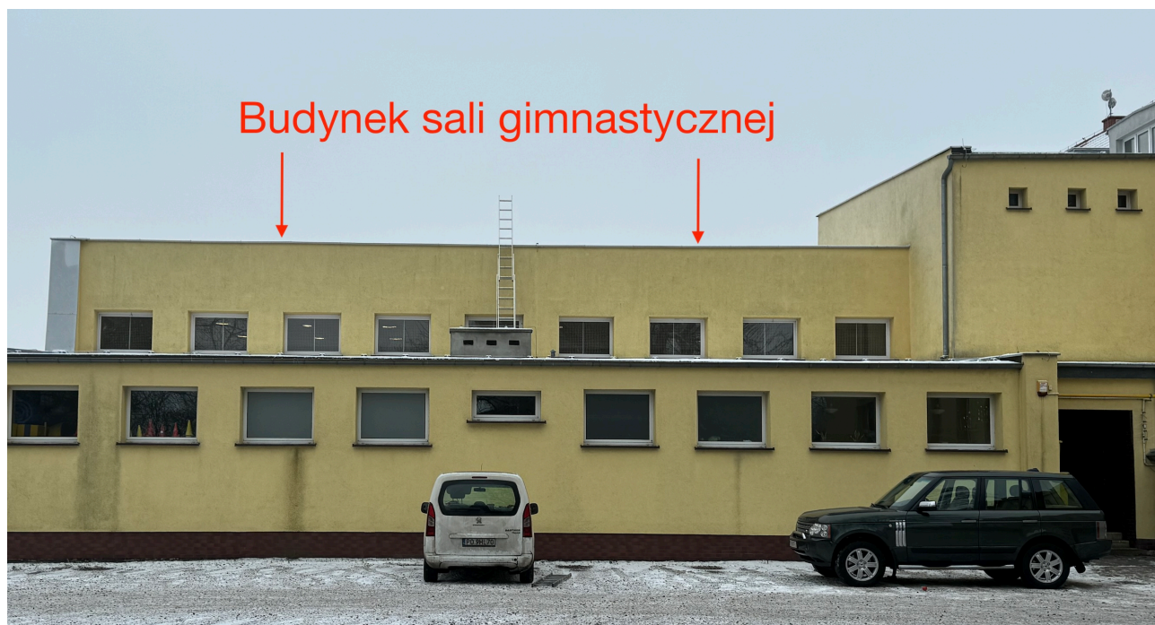
Fot. nr 1. Elewacja frontowa, od strony ul. Kolejowej
