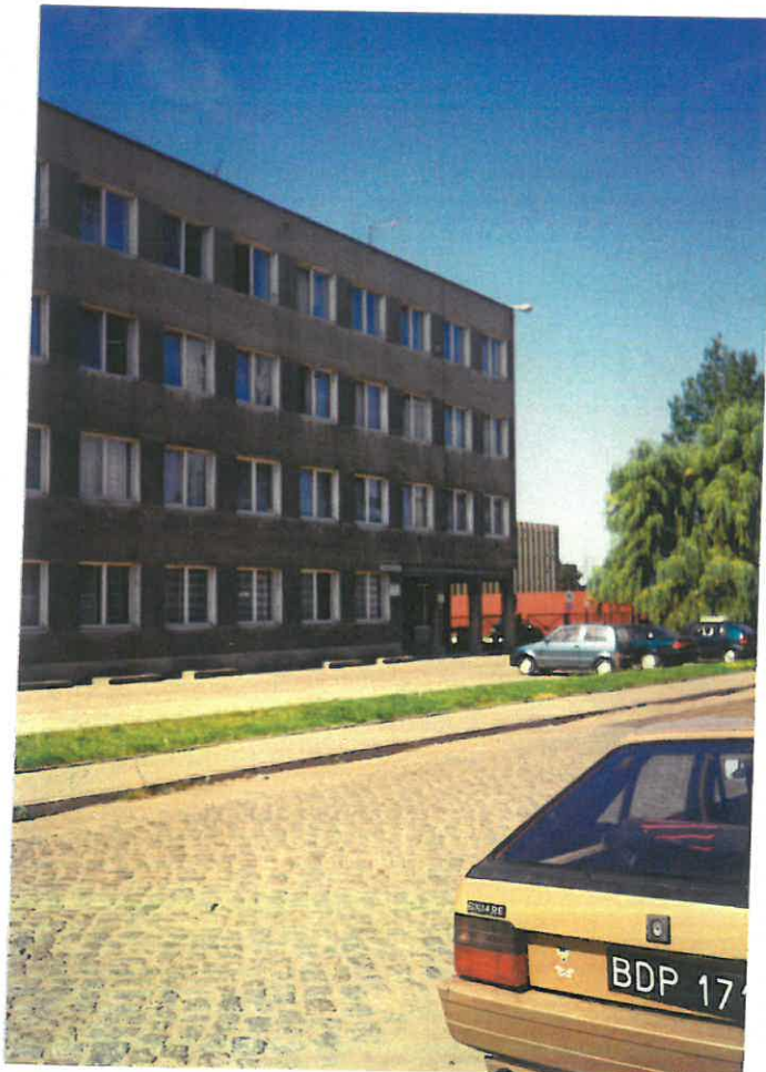
fot.3. Budynek biurowy „A” - fragment elewacji północnej
