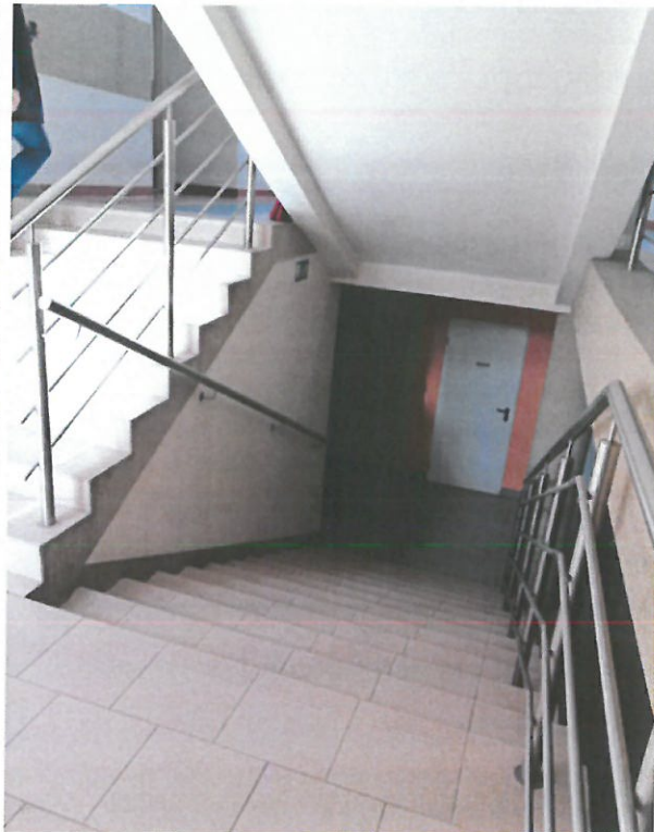
Fot. nr 2 – spocznik (wejście do budynku)
