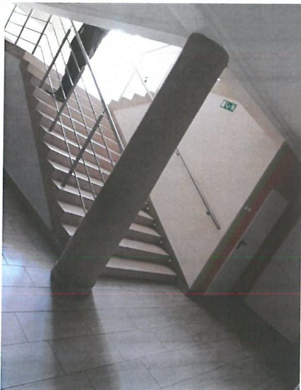
Fot. nr 1 – piwnica
