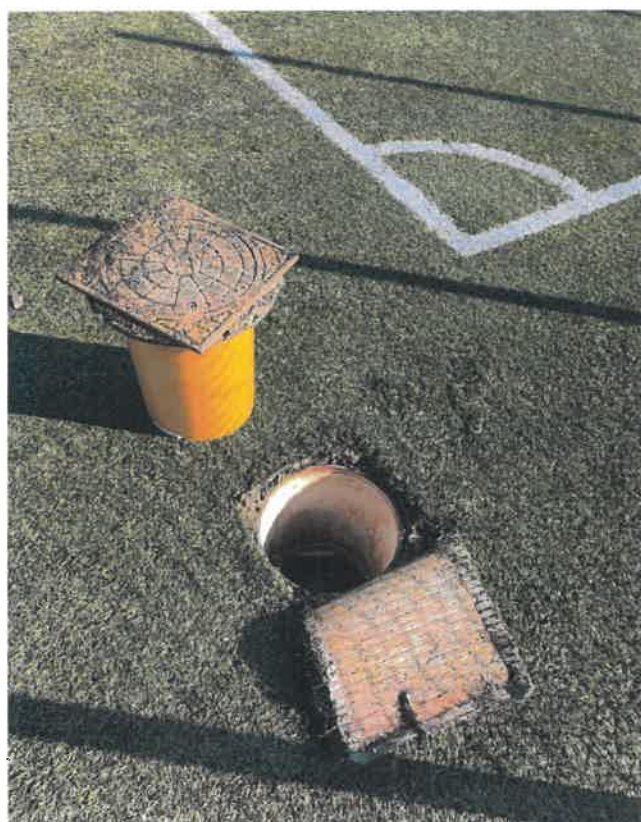
Ilustracja 3: Stan studzienek drenażowych
