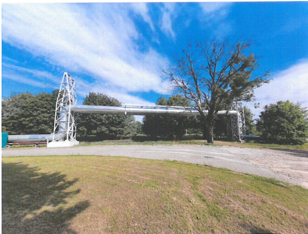
Fot. 1 Widok na konstrukcję.
