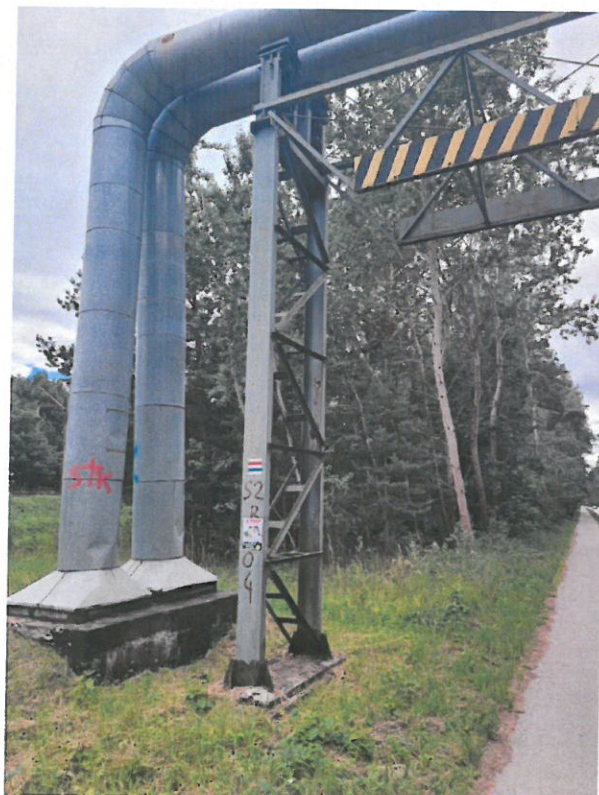
Fot. 48 Podpora KP 2/B/68.
