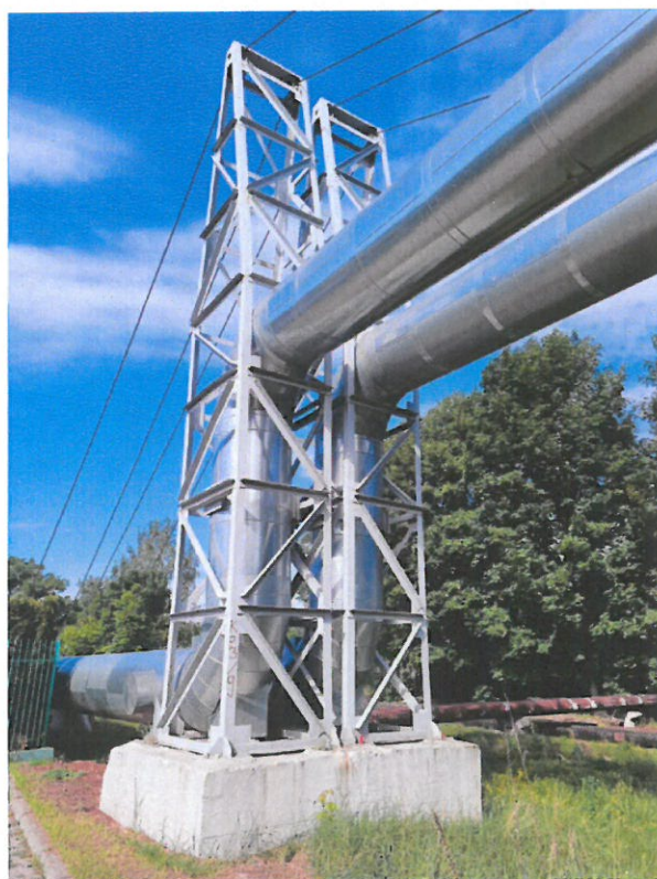
Fot. 2 Podpora KP3/9 (od strony południowej, firmy Jago).
