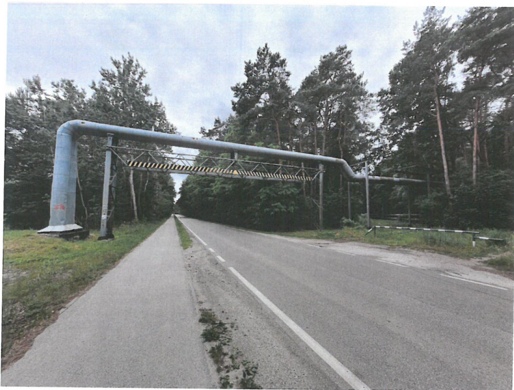
Fot. 47 Estakada nad drogą do Trzcianca. Podpora KP 2/B/68 (po lewej).
