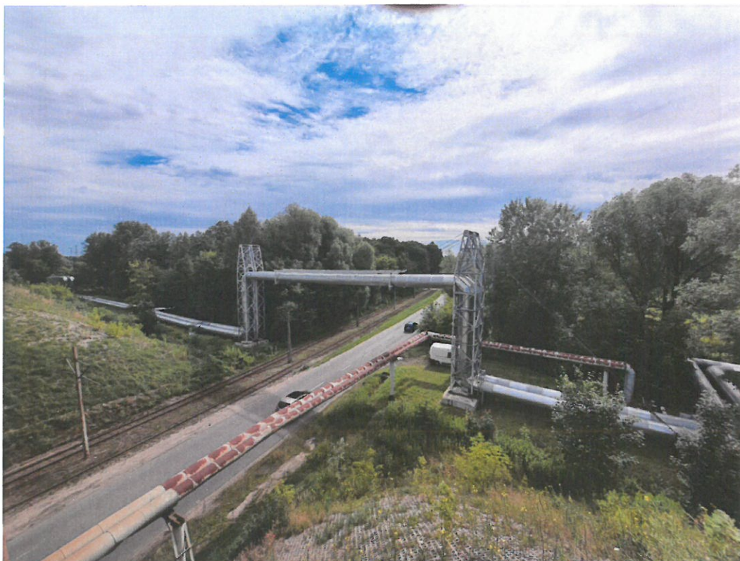
Fot. 1 Widok na konstrukcję.
