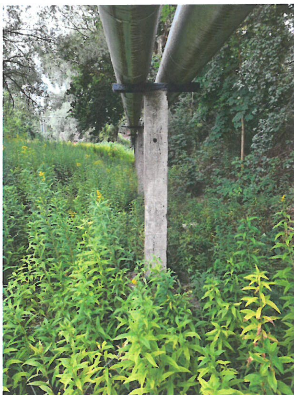
Fot. 18 Podpora nr 16.
