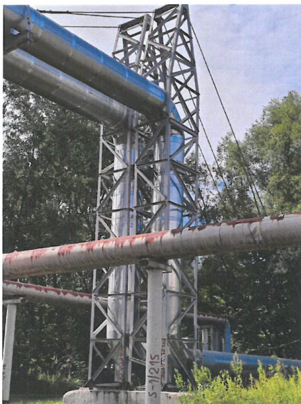
Fot. 2 Podpora KP3/12 (od strony południowej).
