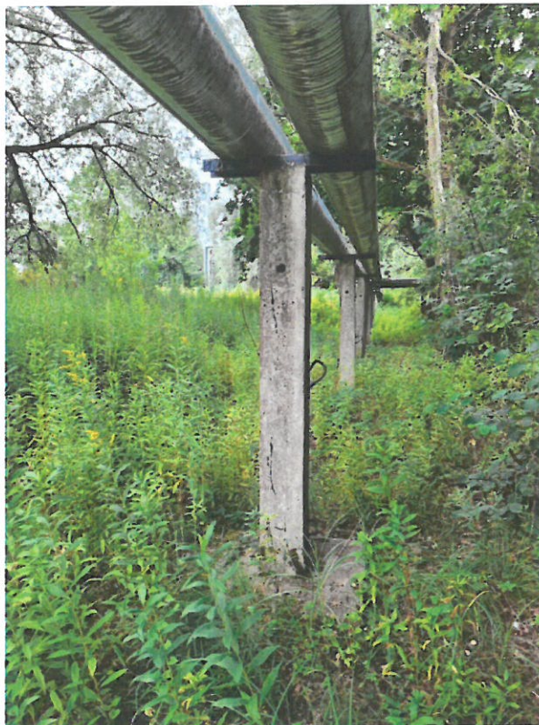
Fot. 17 Podpora nr 15.
