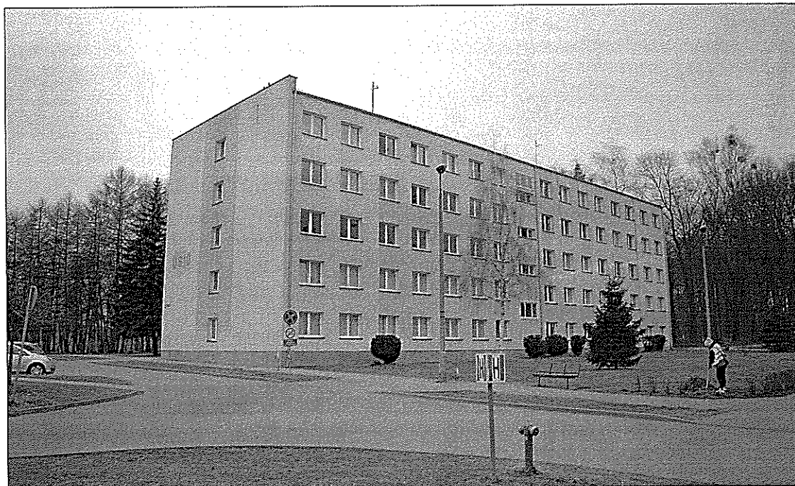
Widok budynku od strony wschodniej
