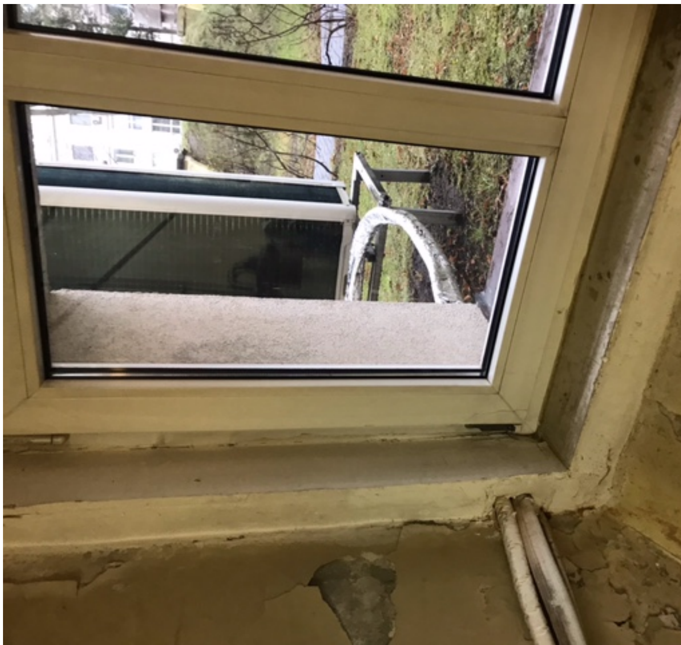
Zdjęcie nr 3: Budynek Muzeum - miejsce planowanego wejścia instalacji do budynku Muzeum (widok z wewnątrz)
