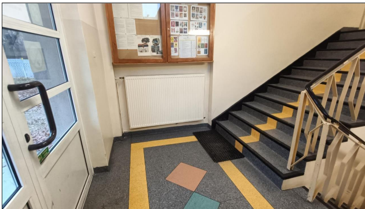
Zdjęcie nr 5 – Budynek przy ul. Witelona 25a. Budowa platformy przyschodowej. Wysoki parter.
