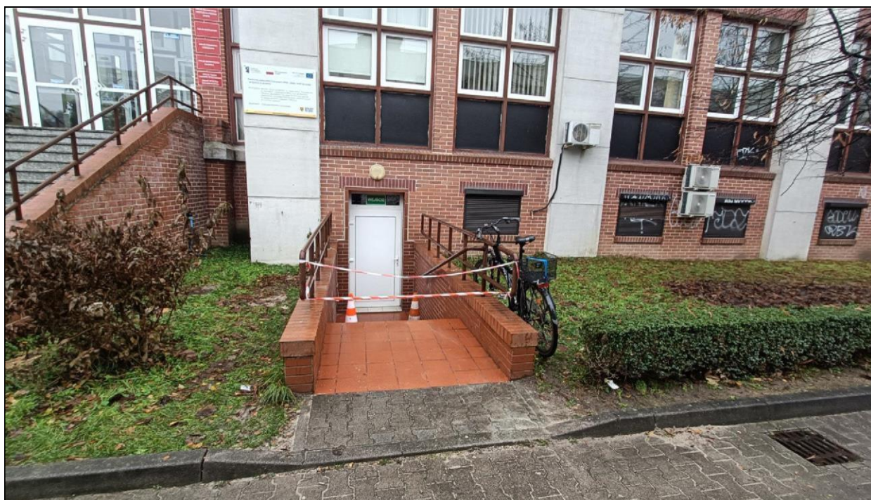
Zdjęcie nr 1 – Dojście do piwnicy w budynku P-2. Wejście z zewnątrz.
