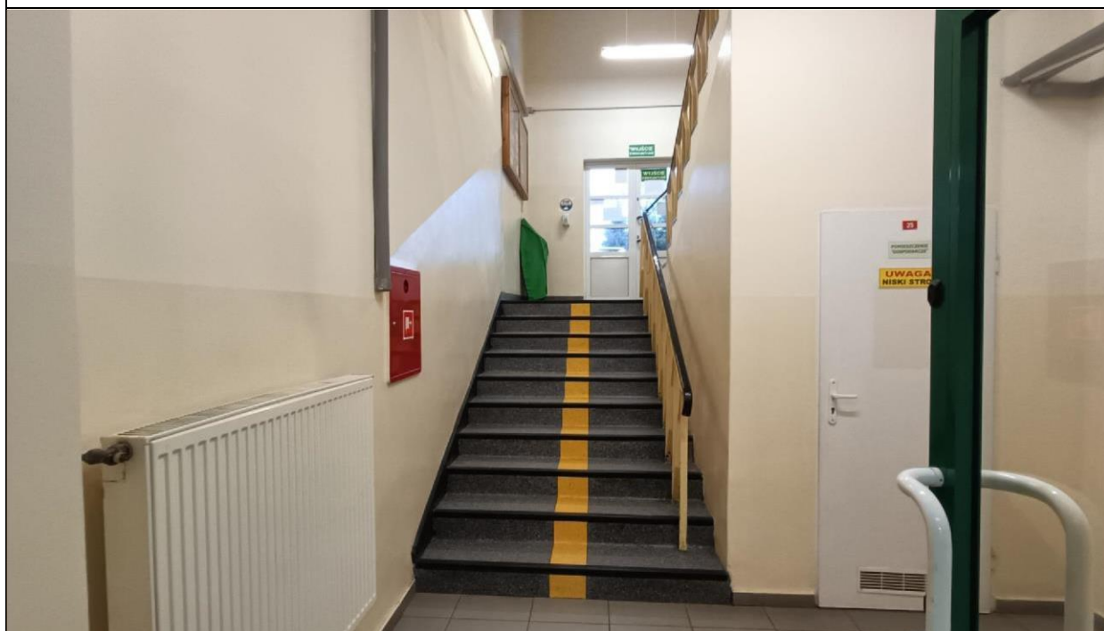
Zdjęcie nr 2 – Budynek przy ul. Witelona 25a. Budowa platformy przyschodowej. Piwnica
