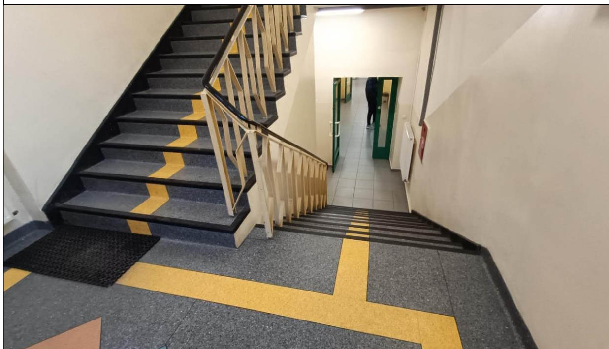
Zdjęcie nr 4 – Budynek przy ul. Witelona 25a. Budowa platformy przyschodowej. Wysoki parter.
