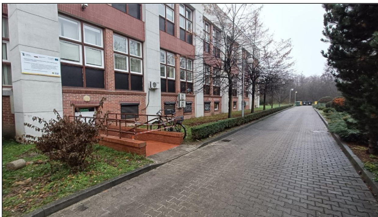
Zdjęcie nr 2 – Dojście do piwnicy w budynku P-2. Wejście z zewnątrz.
