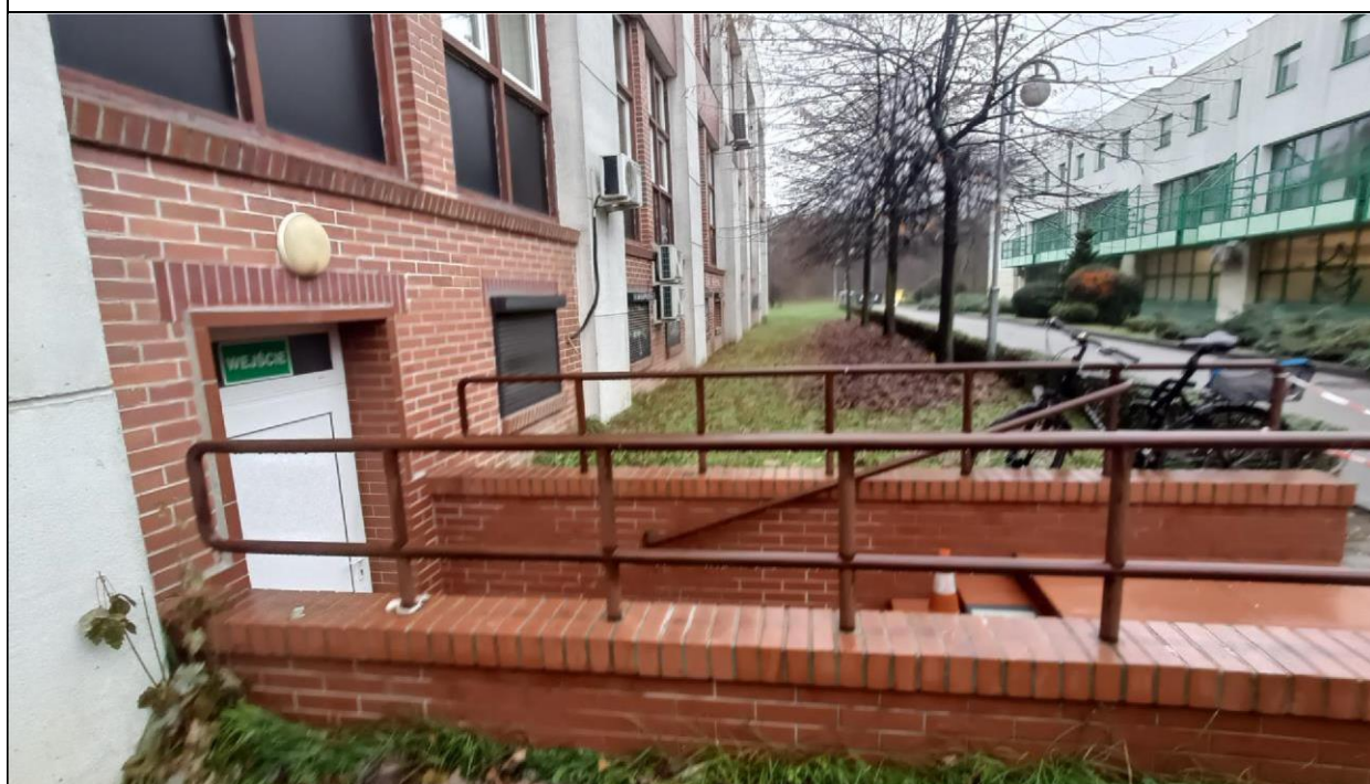
Zdjęcie nr 3 – Dojście do piwnicy w budynku P-2. Wejście z zewnątrz.
