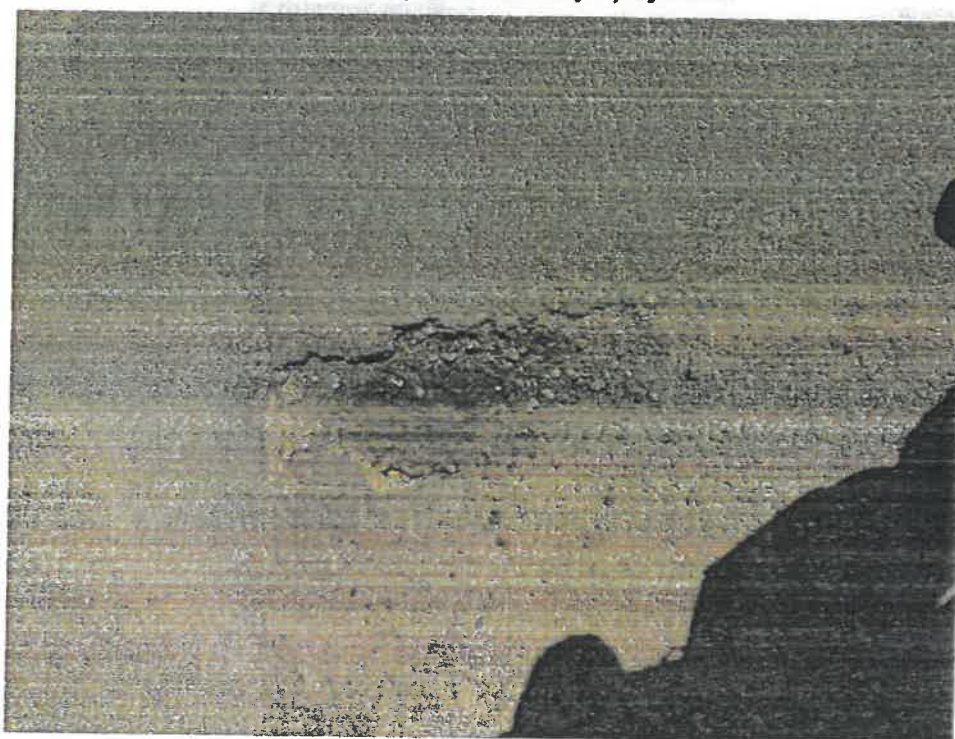
Zdj. 9 Ubytki w nawierzchni asfaltowej.
