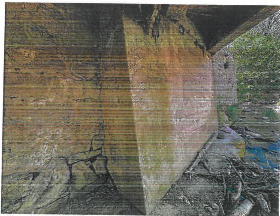
Zdj. 8 Ubytki spoin w kamiennym przyczółku.
