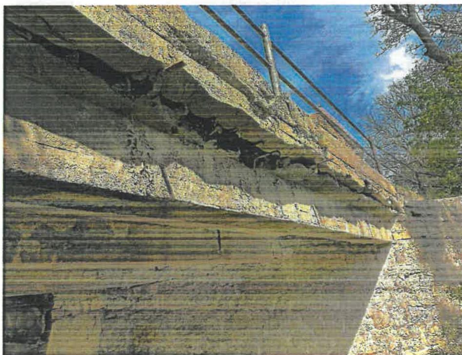
Zdj. 7 Uszkodzony gzyms – pęknięcia, ubytki betonu.
