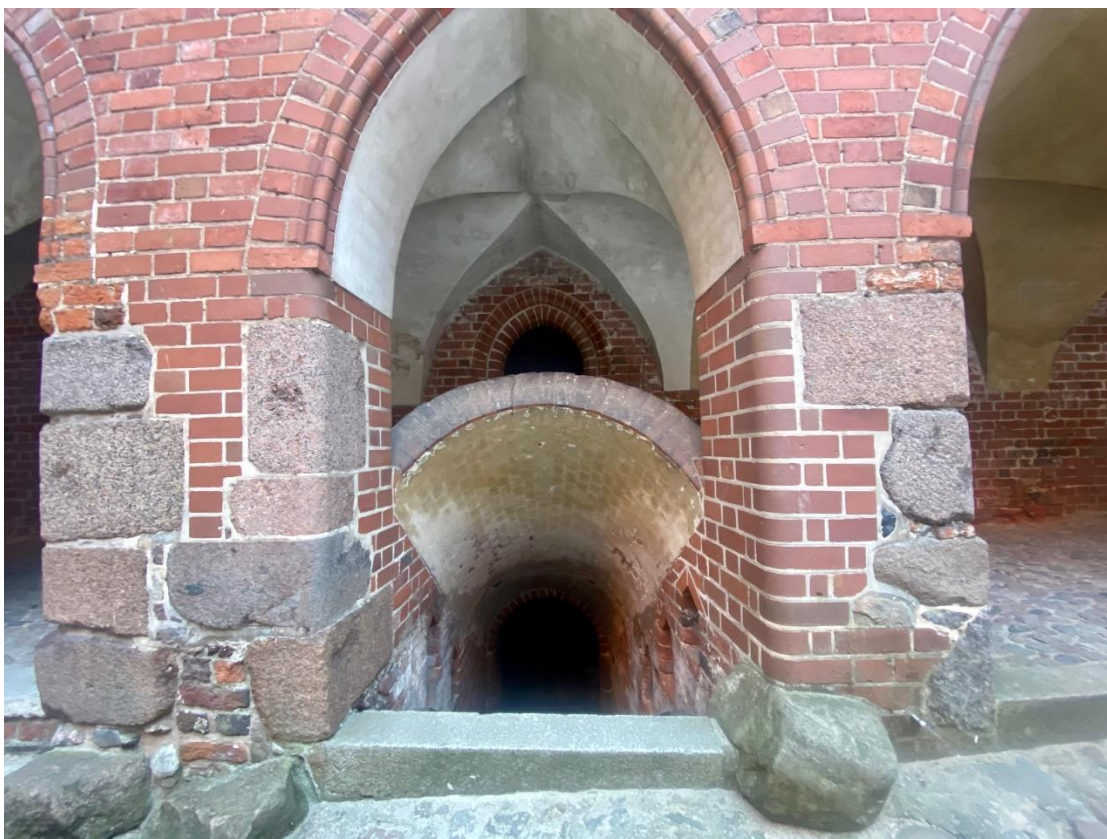
Ilustracja 6 Ciąg komunikacyjny - zejście do piwnic w skrzydle zachodnim.
