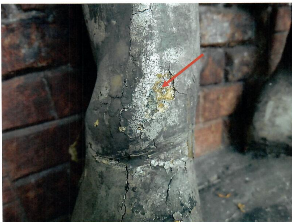
FOT. Nr.10 Przetarcia-odspojenia warstwy srebrzeń( aluminium????) w dolnej partii obiektu .W ubytkach widoczne wcześniejsze warstwy srebrzeń
