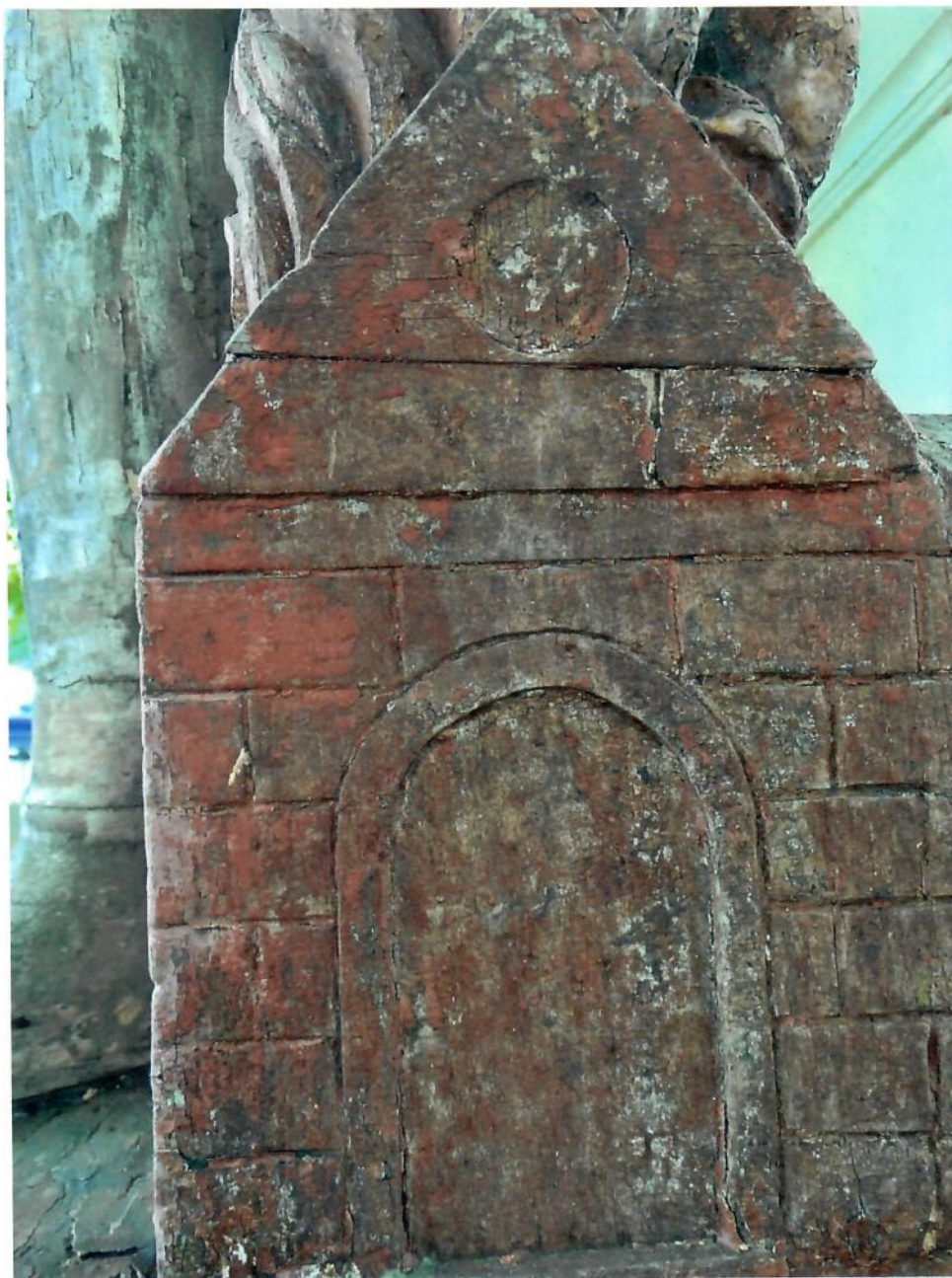
FOT. Nr.8 Przetarcia-odspojenia warstwy polichromii w dolnej partii obiektu
