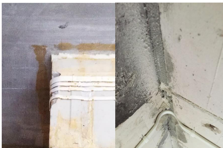
Rys. 2. Przykłady podkucia w narożnikach
