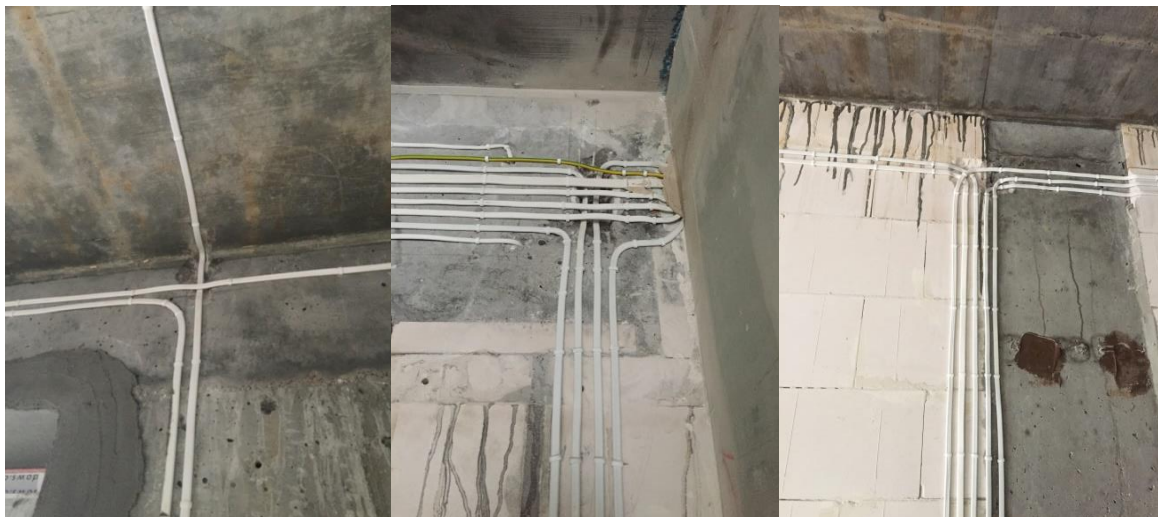
Rys. 3. Przykłady podkucia na skrzyżowaniu kabli
