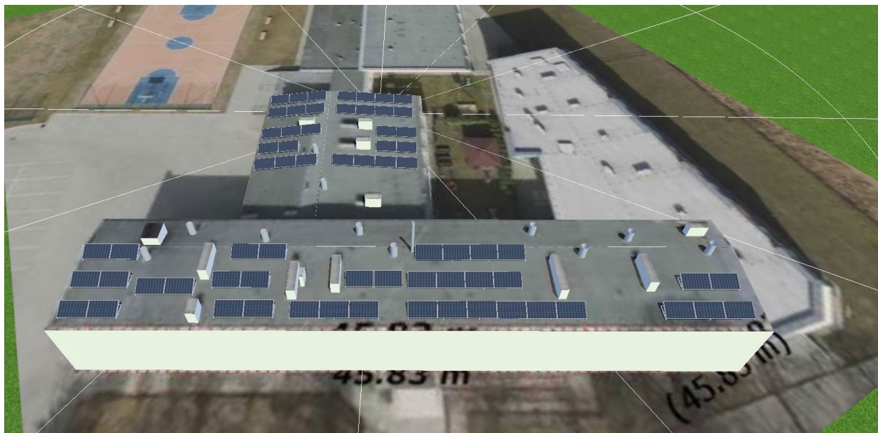
Projektowane sytuowanie paneli na istniejącym budynku
