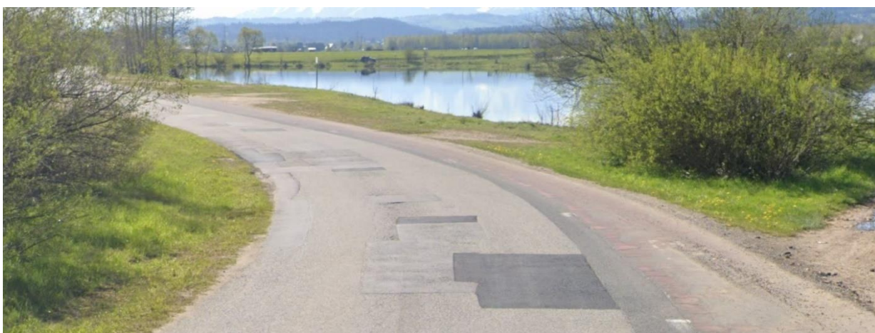
Konieczna do remontu nawierzchnia drogi i ścieżki rowerowej
