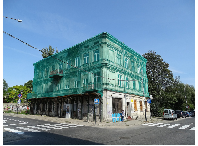
Fot 2 Elewacja – narożnik południowo-zachodni
