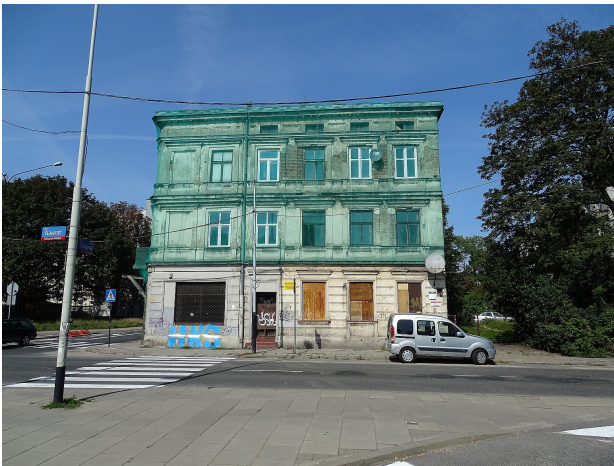
Fot 3 Elewacja południowa
