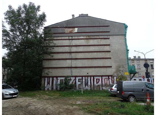
Fot 4 Elewacja północna
