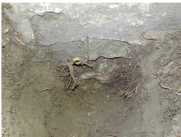
Fot 27 Odkrywka fundamentu – narożnik północno-wschodni
