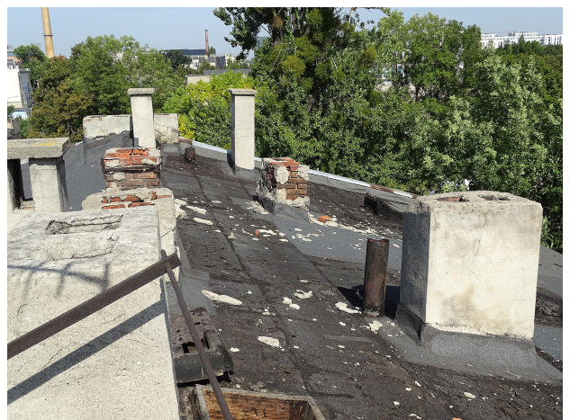
Fot 6 Widok dachu na stronę północną
