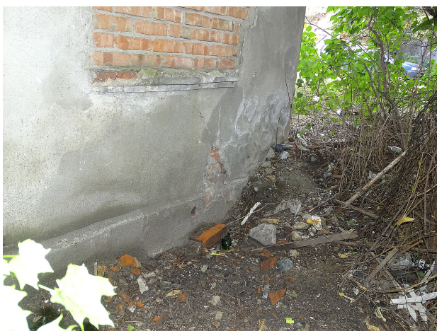
Fot 26 Narożnik północno-wschodni
