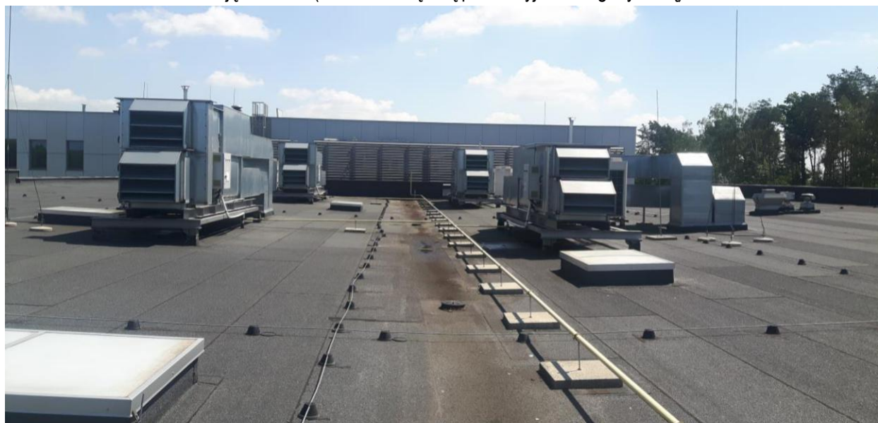
Zdjęcie nr 18 (dach nad częścią produkcyjno - magazynową)
