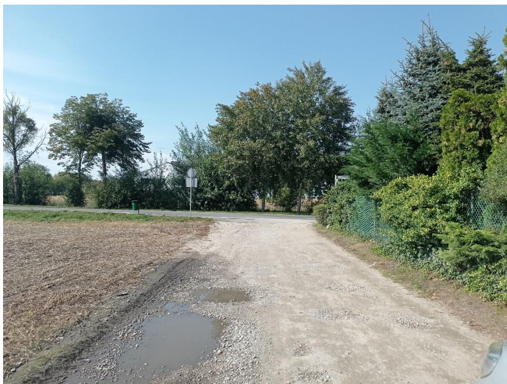
Fot. 2. Zjazd z ul. Leśnej w ul. Szafirową
