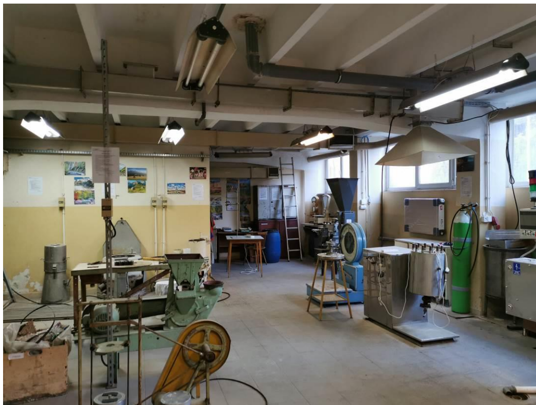
Pomieszczenia 02/03(warzelnia) w piwnicy
