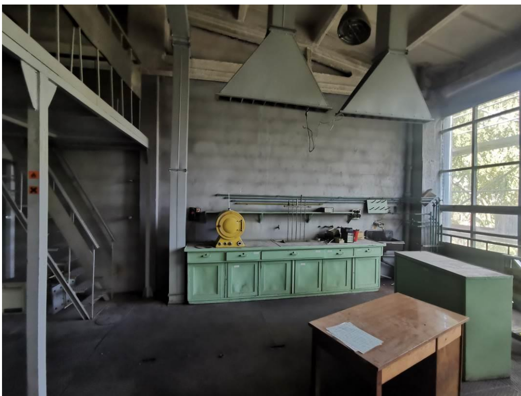
Pomieszczenie hali 1/4 techniki na II-gim piętrze
