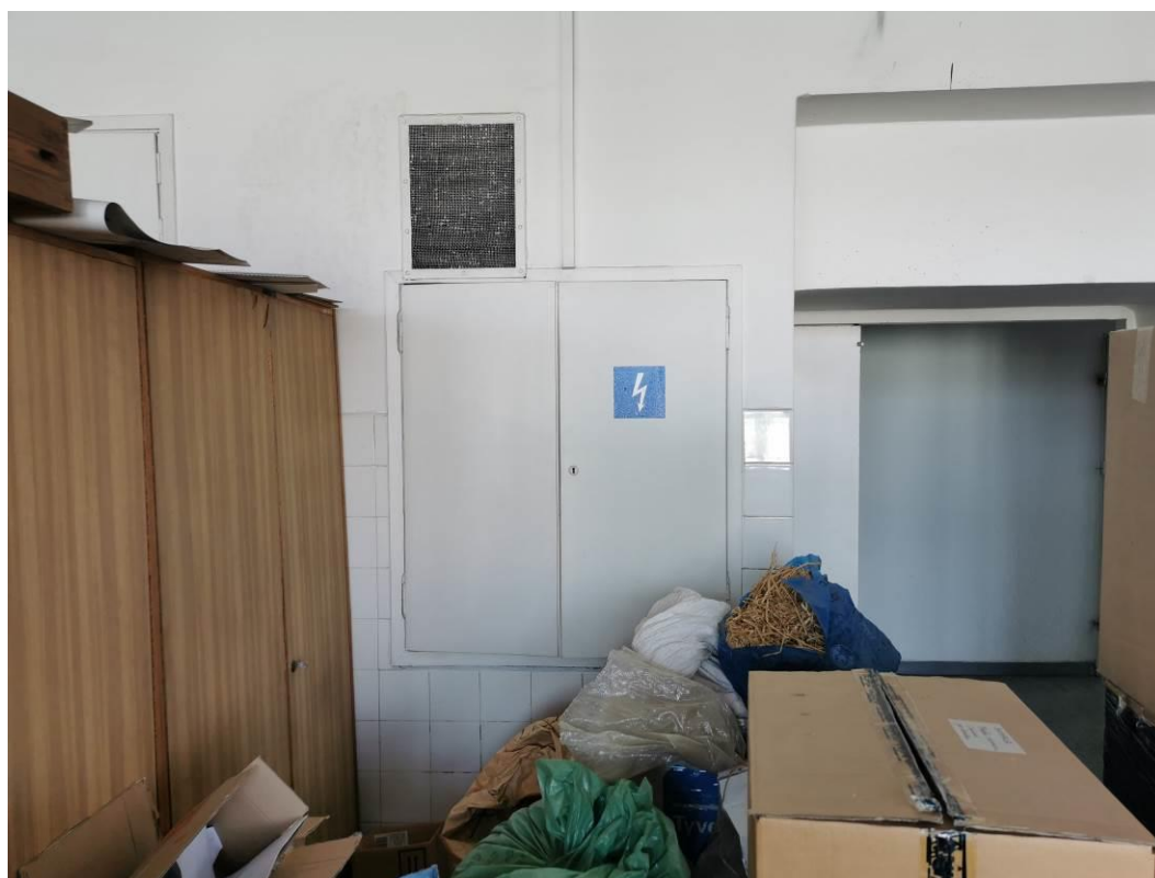
Pomieszczenie 201 na II-gim piętrze
