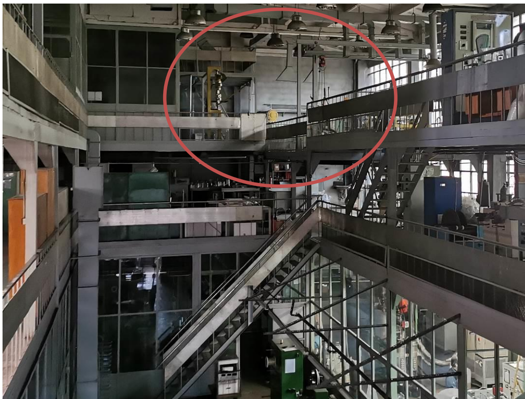
Pomieszczenie hali 1/4 techniki na II-gim piętrze
