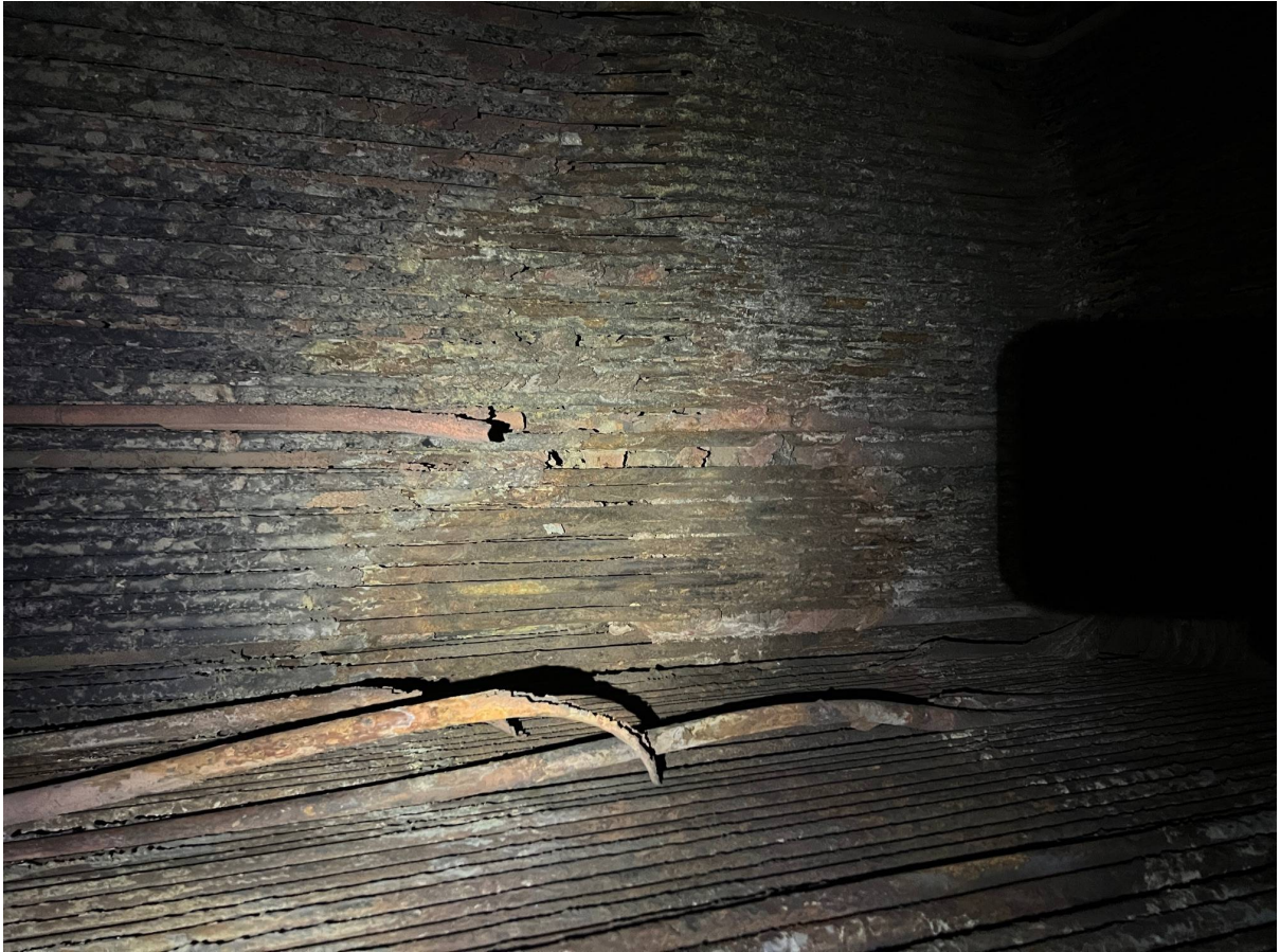
Fotografia 2: Pęczek ekranu z rurami wodnymi z widocznymi rozwarstwieniami rur wodnych
