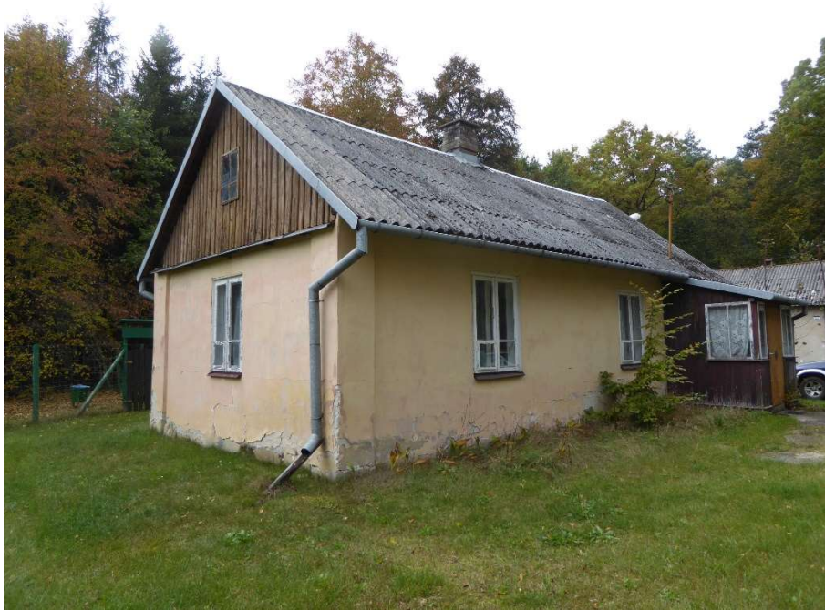
1. Budynek mieszkalny – widok zewnątrz budynku
