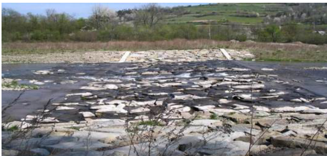
Bystrze regularne na potoku Porębianka
