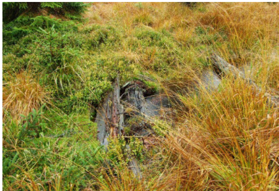
Sukcesja roślinna na zablizniającym się rowie i rozpadające się przytamańce – skutecznie spełniło swoją rolę – Nadleśnictwo Szklarska Poręba, Źródło: Archiwum CKPS
