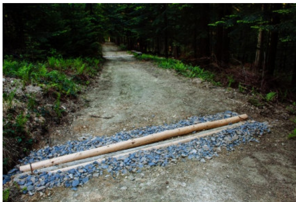
Wodospust z okrągłaków – Nadleśnictwo Gorlice
