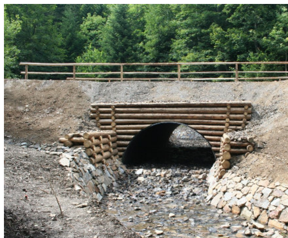
Przebudowa przepustu na nowoczesną konstrukcję odporną na zatkanie rumoszem. Źródło: Materiały własne Nadleśnictwa Baligród.
