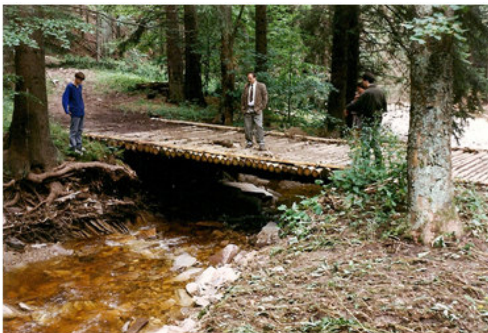
Mostek ocalały w stanie nienaruszonym po przejściu fali powodziowej o metr nad nim w 1997 roku – Nadleśnictwo Zdroje. Fot. B. Noga. Źródło: Archiwum CKPŚ.
