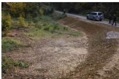
Zbiorniki na spływy powierzchniowe w N-ctwie Piwniczna
