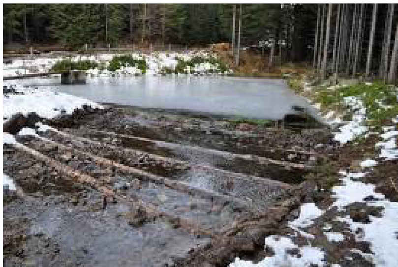
Przelewy górne w zbiornikach w N-ctwie Bielsko
