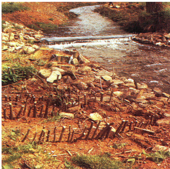
Płotek ze zrzezów wierzbowych tuż po wykonaniu (Begemann i Schiechl 1999)
