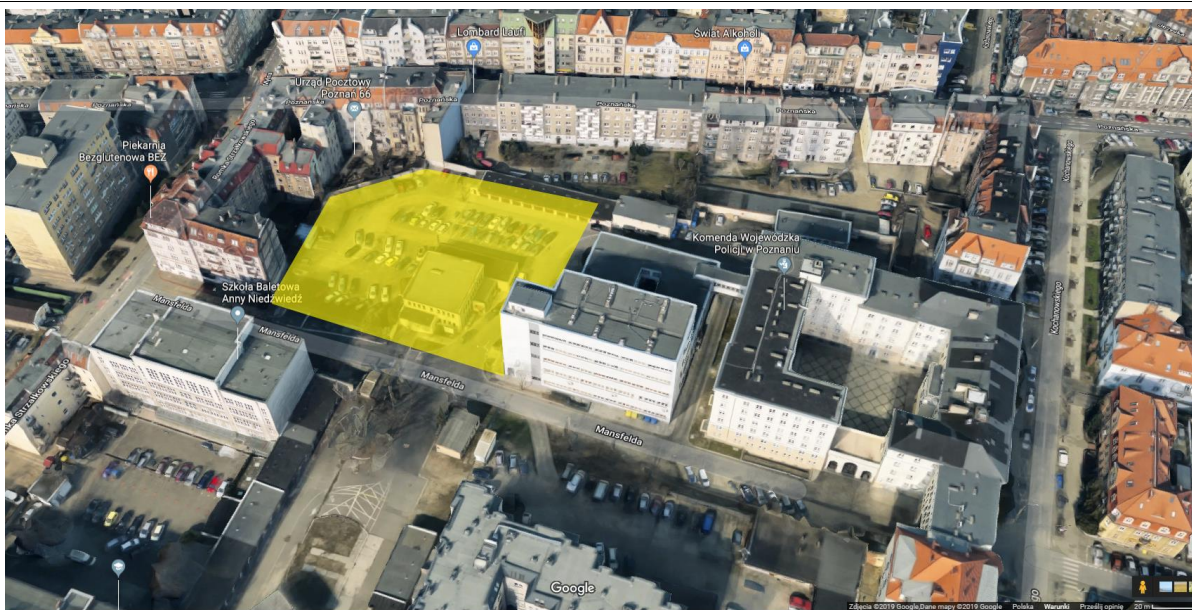
Fot. 1 – teren przewidziany pod budowę budynku Laboratorium Kryminalistycznego Komendy Wojewódzkiej Policji w Poznaniu
