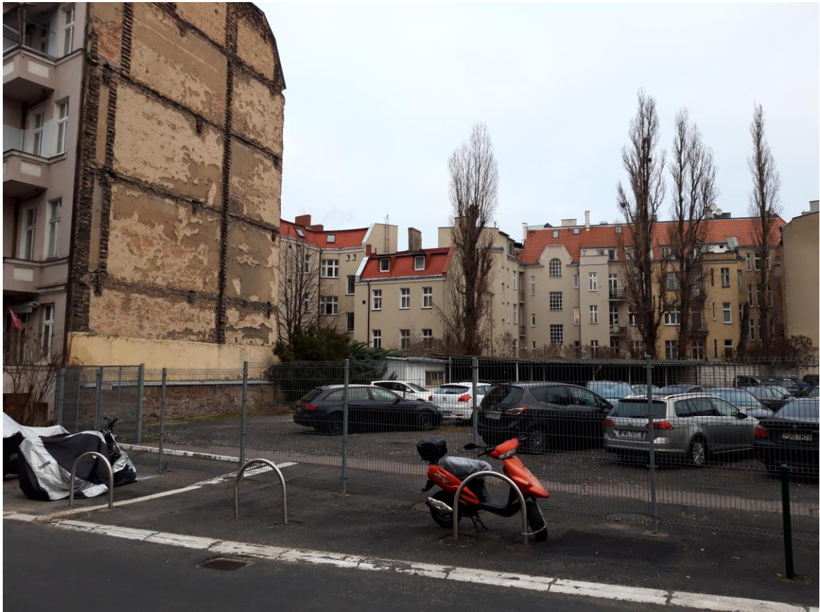
Fot. 3 - teren przewidziany pod budowę budynku Laboratorium Kryminalistycznego Komendy Wojewódzkiej Policji w Poznaniu - widok z ulicy Mansfelda.
