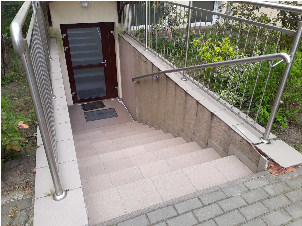
3. Zejście do piwnicy
