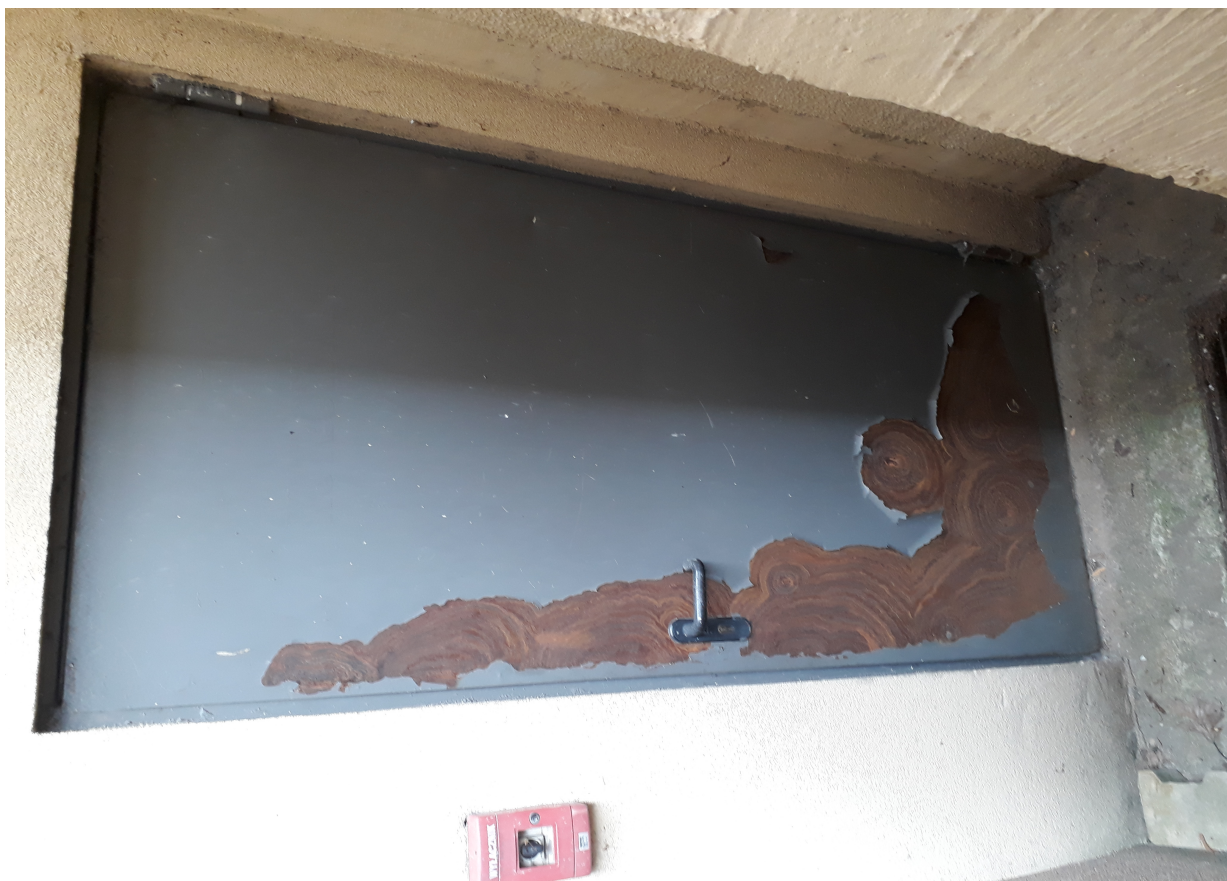
2. Zejście do kotłowni – malowanie drzwi
