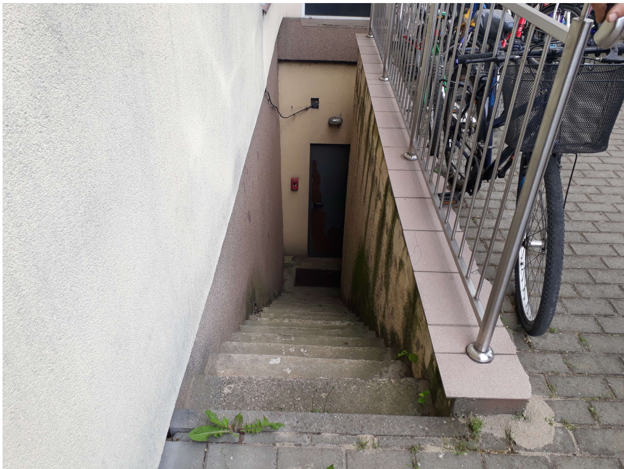
1. Zejście do kotłowni
