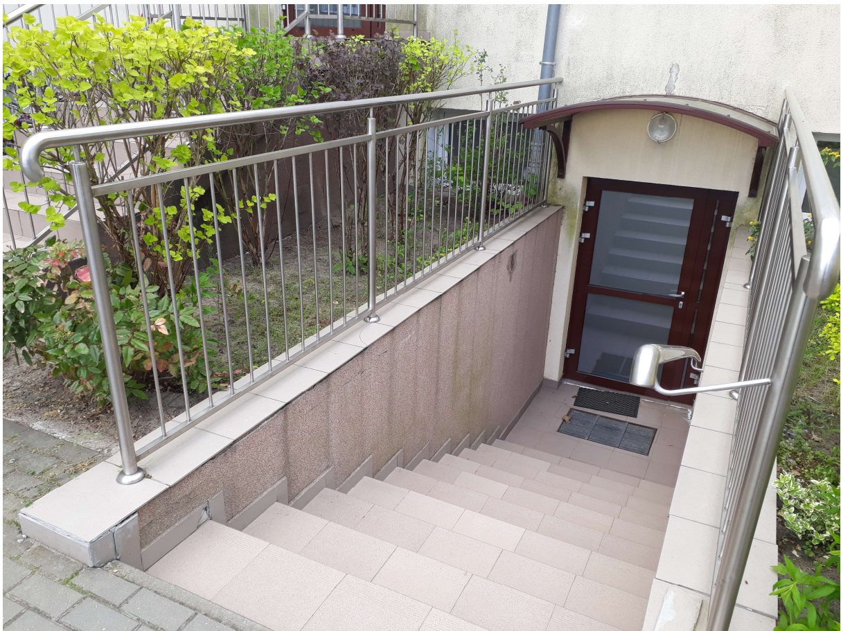
4. Zejście do piwnicy
