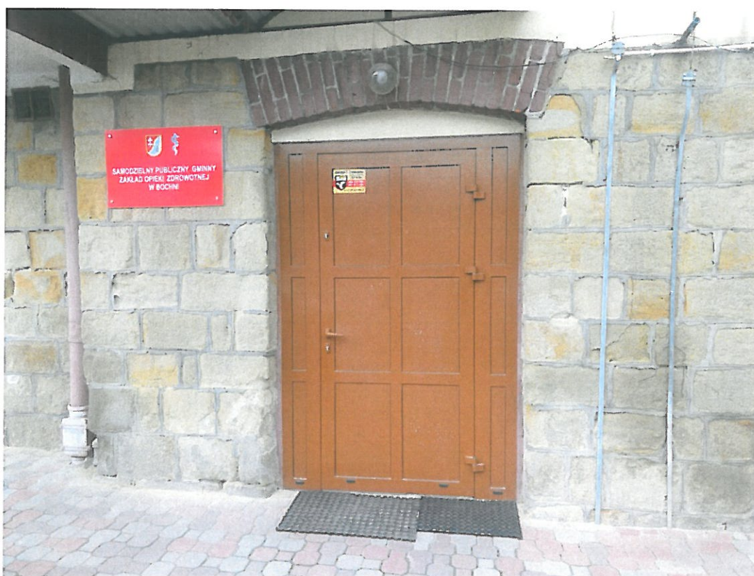
Fot. 3-06. Bochnia, kamienica przy ul. Kazimierza Wielkiego 26, program prac konserwatorskich. Elewacja tylna, południowa,
