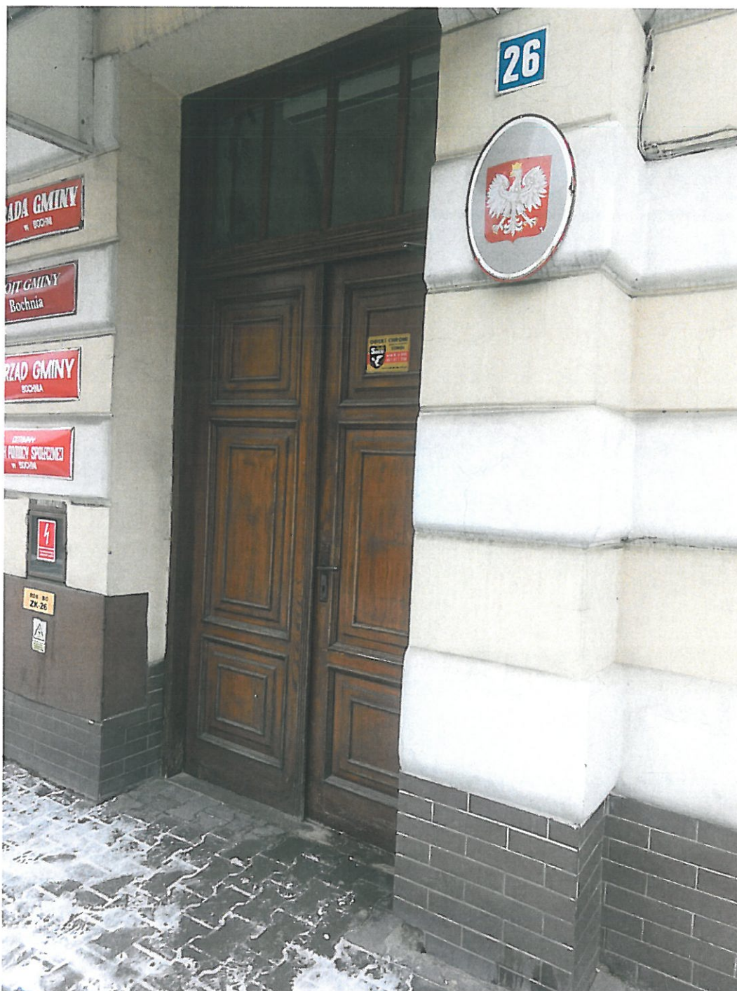
Fot. 1-09. Bochnia, kamienica przy ul. Kazimierza Wielkiego 26, program prac konserwatorskich. Elewacja północna w przyziemiu. Widoczna okładzina ceramiczna dolnego pasa boni w do budynku. Do usunięcia.
