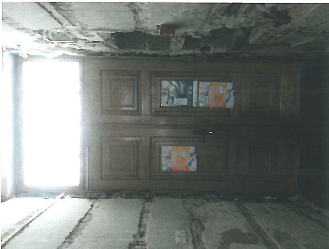
Fot. 4-08. Bochnia, kamienica przy ul. Kazimierza Wielkiego 26, program prac konserwatorskich. Widok ogólny drzwi dwuskrzydłowych w elewacji frontowej północnej od strony sieni,
