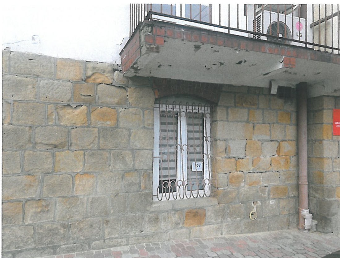
Fot. 3-04. Bochnia, kamienica przy ul. Kazimierza Wielkiego 26, program prac konserwatorskich. Elewacja tylna, południowa, aktualny stan zachowania cokołu kamiennego.
