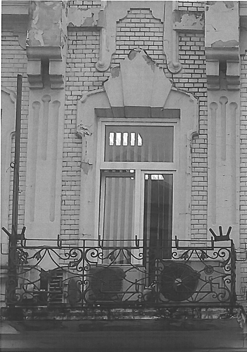
Fot. 1-17. Bochnia, kamienica przy ul. Kazimierza Wielkiego 26, program prac konserwatorskich. Elewacja północna, obramienie drzwi balkonowych. Widoczny zakres zniszczeń:
