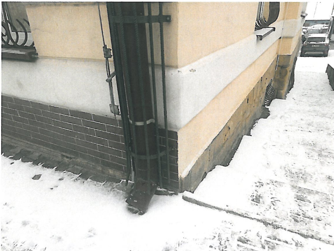
Fot. 1-08. Bochnia, kamienica przy ul. Kazimierza Wielkiego 26, program prac konserwatorskich. Elewacja północna, narożnik zachodni w przyziemiu. Widoczna okładzina ceramiczna dolnego pasa boni
