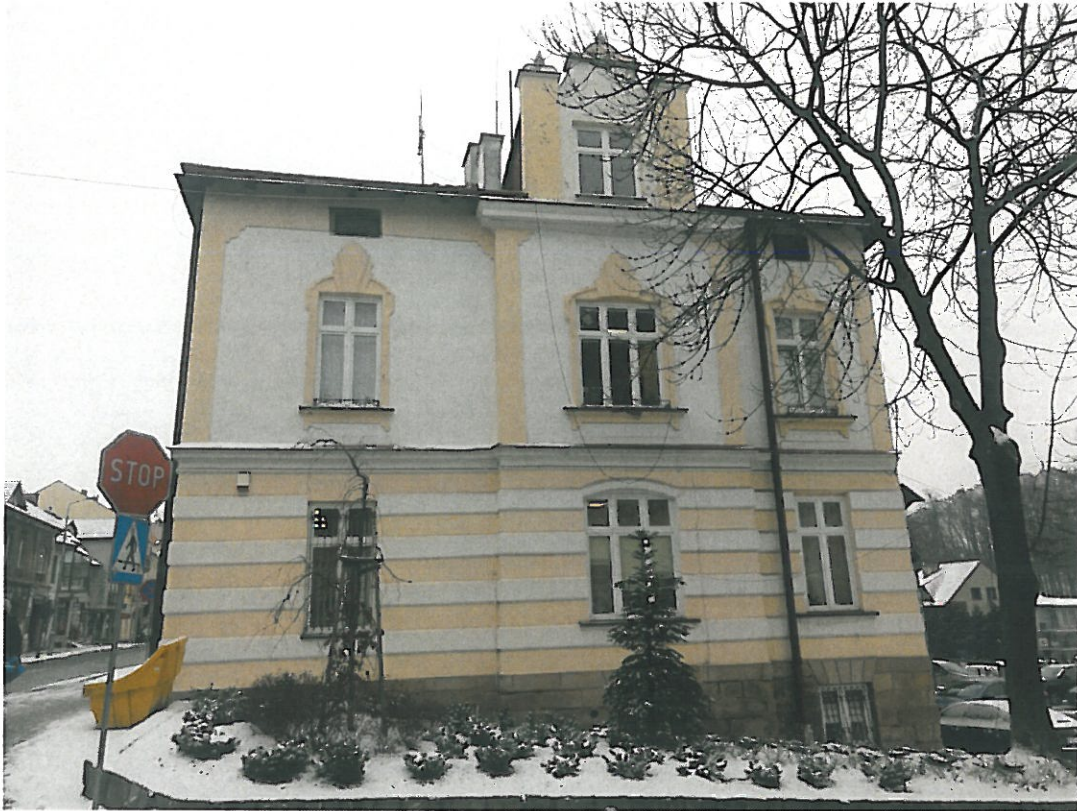
Fot. 2-01. Bochnia, kamienica przy ul. Kazimierza Wielkiego 26, program prac konserwatorskich. Elewacja boczna, zachodnia, aktualny stan zachowania. Widok ogólny.
