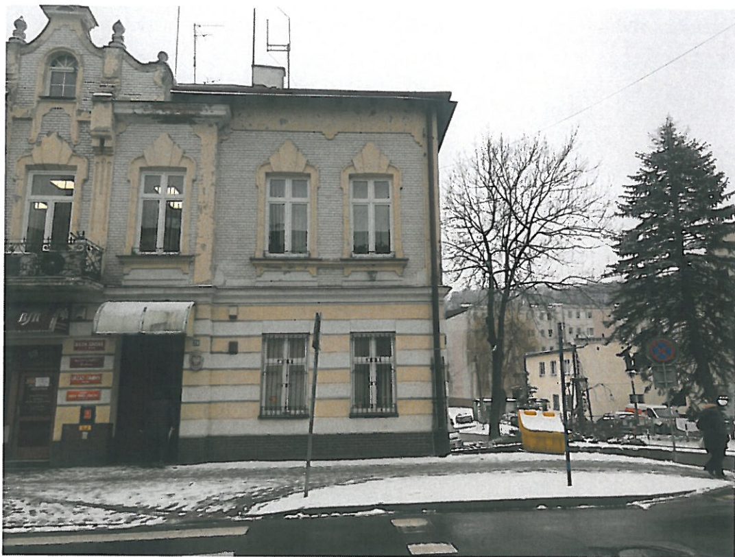
Fot. 1-04. Bochnia, kamienica przy ul. Kazimierza Wielkiego 26, program prac konserwatorskich. Widok ogólny elewacji frontowej północne – fragment ryzalitu z wejściem do budynku i ściana po zachodniej stronie ryzalitu
