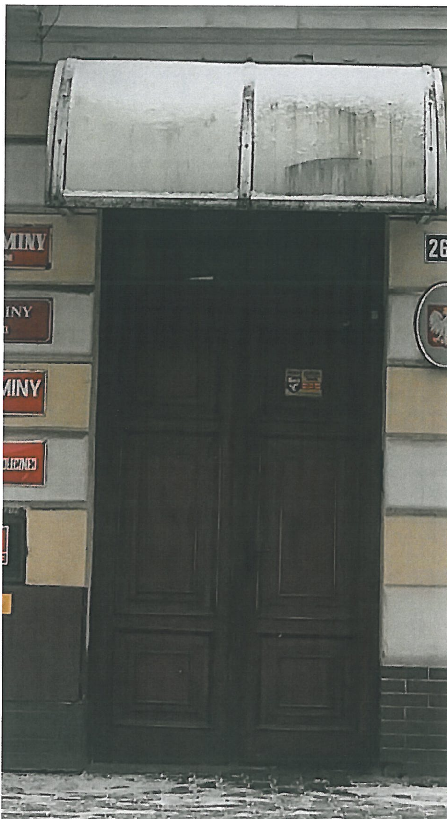
Fot. 1-18. Bochnia, kamienica przy ul. Kazimierza Wielkiego 26, program prac konserwatorskich. Elewacja północna, drzwi wejściowe, widok od strony zewnętrznej. Drzwi dwuskrzydłowe. Płycinowe, z nadświetlem.
