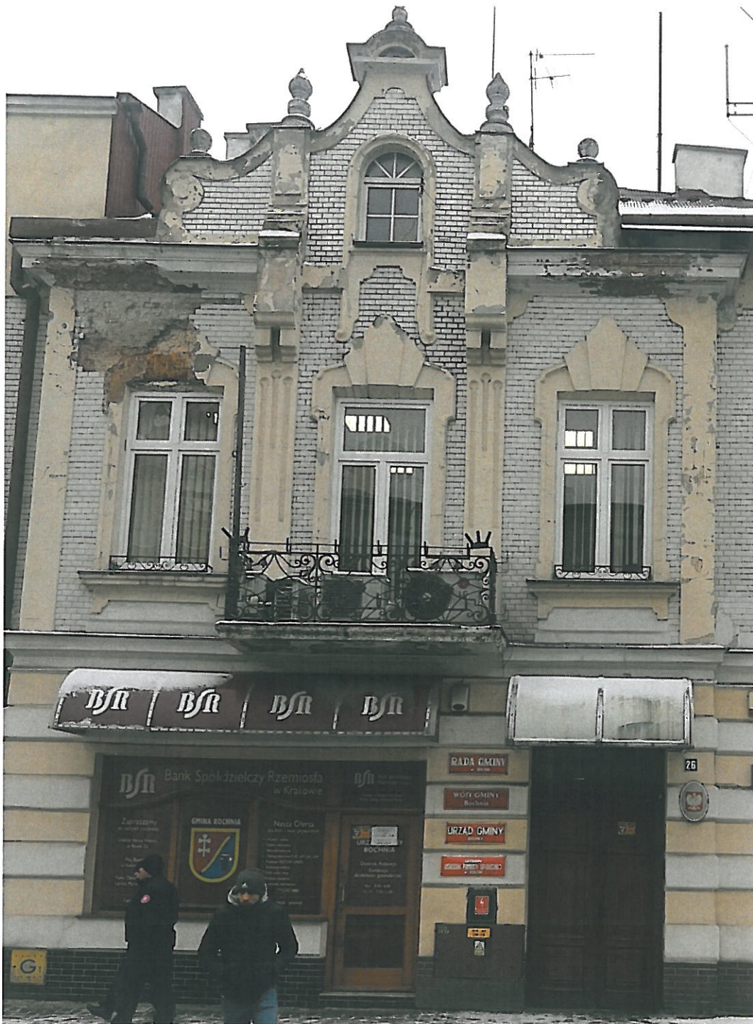
Fot. 1-05. Bochnia, kamienica przy ul. Kazimierza Wielkiego 26, program prac konserwatorskich. Elewacja frontowa ryzalitu, aktualny stan zachowania fasady. Kompozycja wystroju architektonicznego, składająca się z:
