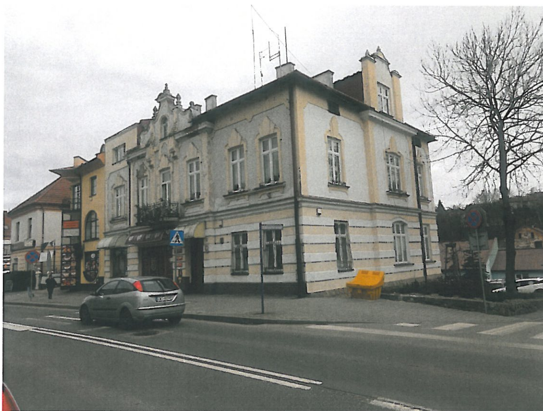
Fot. 0-01. Bochnia, kamienica przy ul. Kazimierza Wielkiego 26, program prac konserwatorskich. Widok ogólny elewacji frontowej, północnej i bocznej zachodniej, Stan zachowania – styczeń 2023r.
