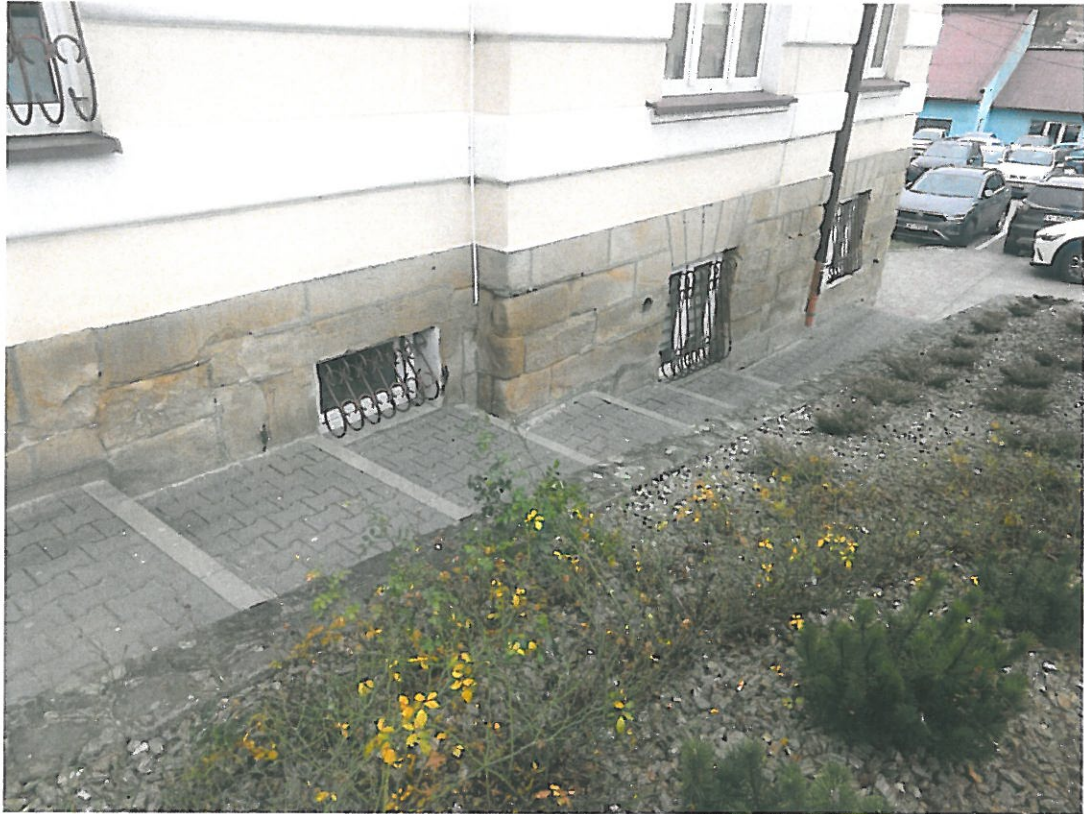
Fot. 2-03. Bochnia, kamienica przy ul. Kazimierza Wielkiego 26, program prac konserwatorskich. Elewacja boczna, zachodnia, widok ogólny cokołu kamiennego, aktualny stan zachowania.
