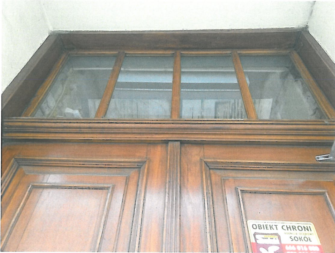
Fot. 4-04. Bochnia, kamienica przy ul. Kazimierza Wielkiego 26, program prac konserwatorskich. Widok górnego fragmentu skrzydeł i nadświetla w elewacji frontowej północnej., widoczne ubytki i przetarcia powłoki malarskiej
