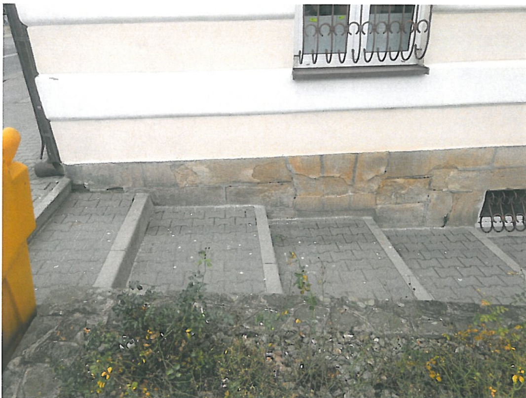
Fot. 2-02. Bochnia, kamienica przy ul. Kazimierza Wielkiego 26, program prac konserwatorskich. Elewacja boczna, zachodnia, Fragment cokołu kamiennego od strony północnej, przesłoniętego schodami
