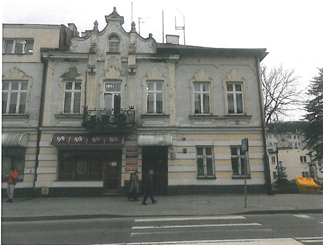
Fot. 0-01. Bochnia, kamienica przy ul. Kazimierza Wielkiego 26, program prac konserwatorskich. Widok ogólny elewacji frontowej, północnej, stan zachowania – styczeń 2023.
