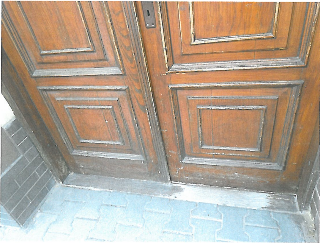
Fot. 4-06. Bochnia, kamienica przy ul. Kazimierza Wielkiego 26, program prac konserwatorskich. Widok dolnego fragmentu skrzydła prawego i lewego w elewacji frontowej północnej., widoczne ubytki i przetarcia powłoki malarskiej
