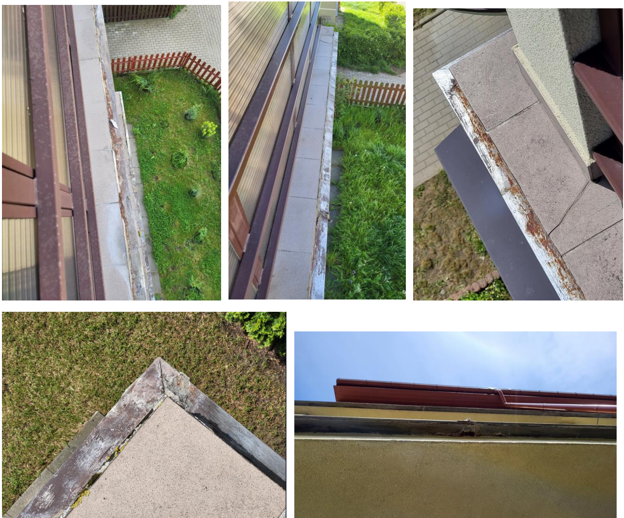
Zdjęcia obróbki balkonu - przykłady
