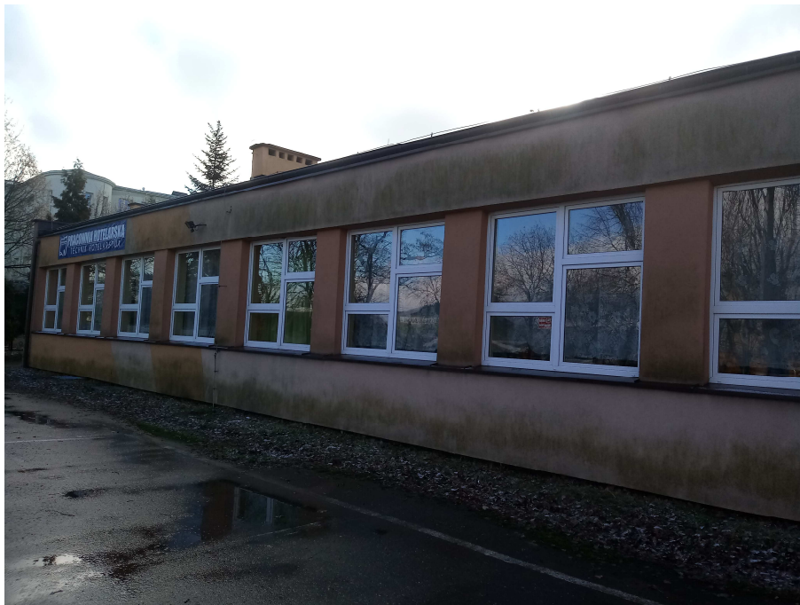
3.1 Część budynku objęta opracowaniem, widok od strony północnej.
